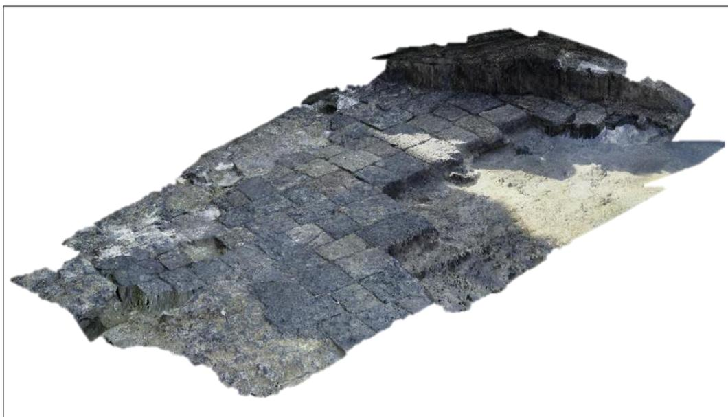
Figura 73. Rilievo fotogrammetrico in tre dimensioni della pavimentazione
