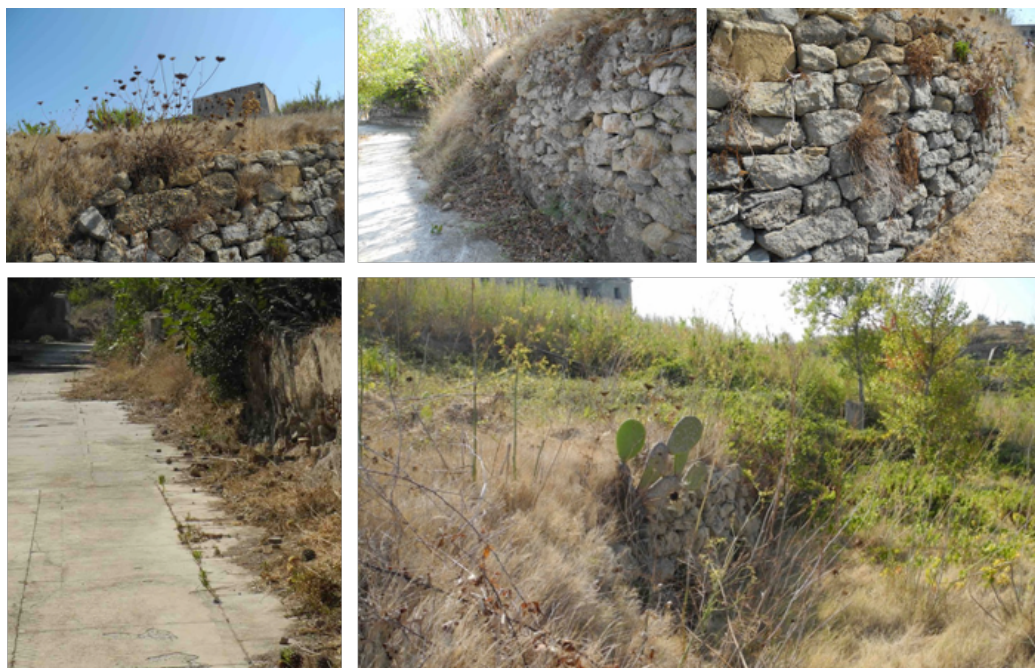
Figura 5 – Diversità dello stato di conservazione dei muretti a secco lungo i percorsi di accesso al carcere e al cimitero
