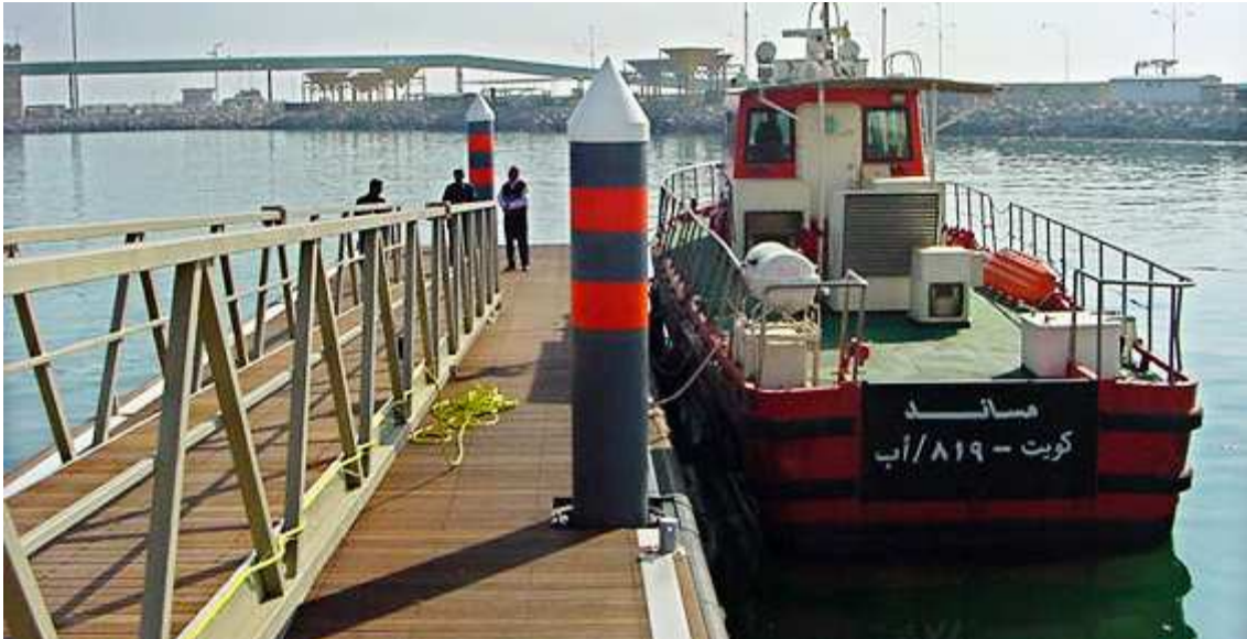
Figura 4-2 – esempio di pontile galleggiante vincolato a pali
