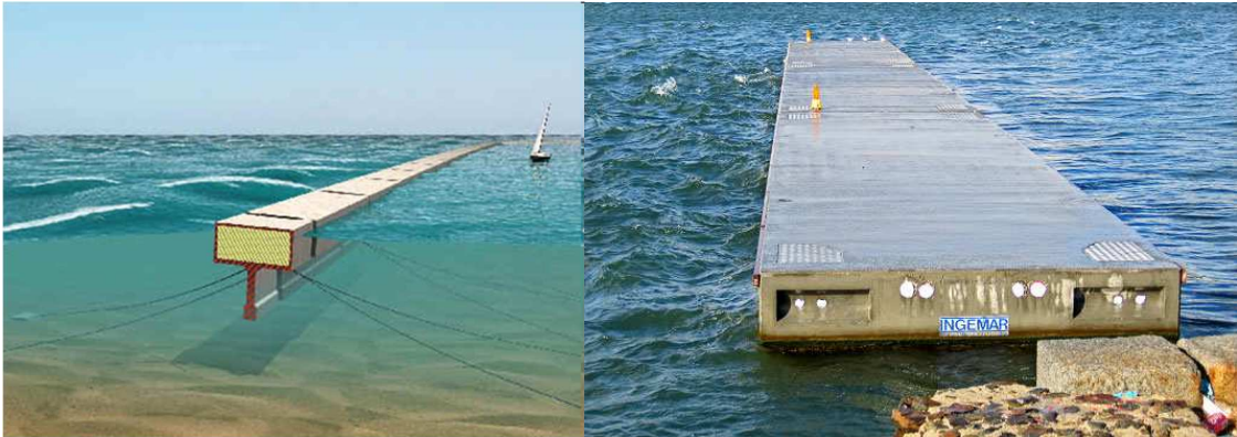
Figura 4-1 – opere di difesa dal moto ondoso di tipo galleggiante
