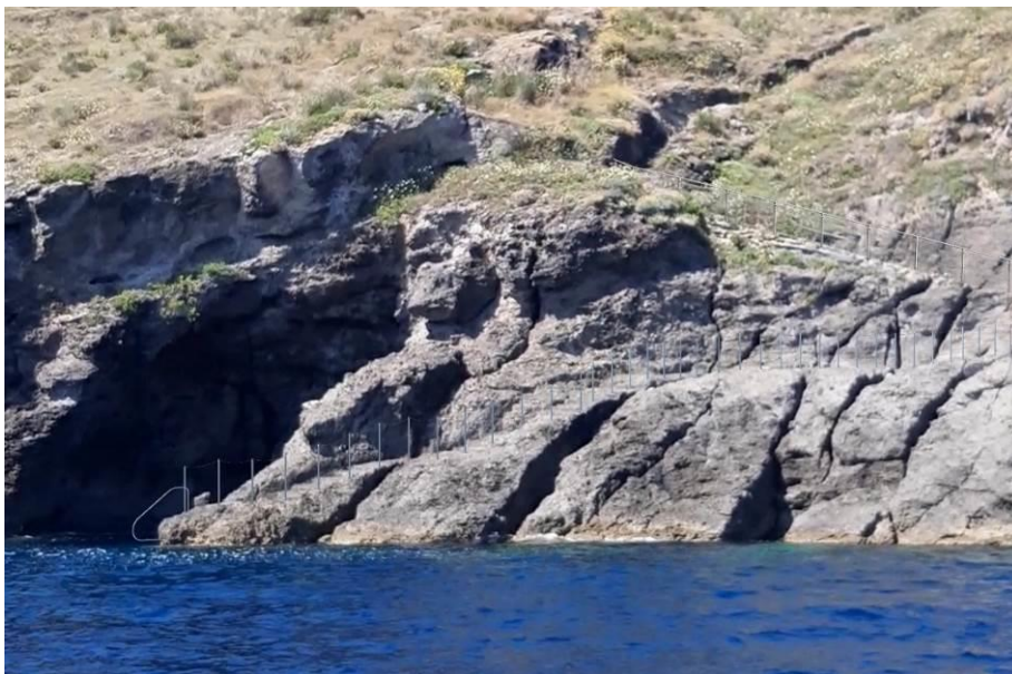
Figura 33. Vista da mare, condizione post operam
