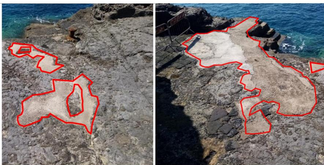
Figura 28. Eliminazione inserti in cls sulla scogliera
