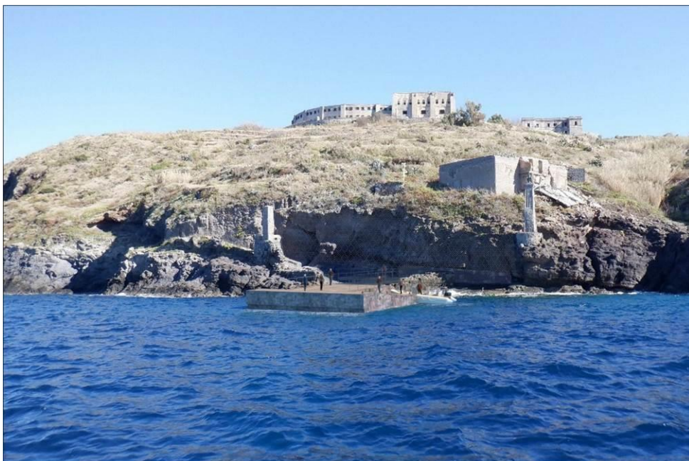
Figura 12. Vista da mare, condizione post operam
