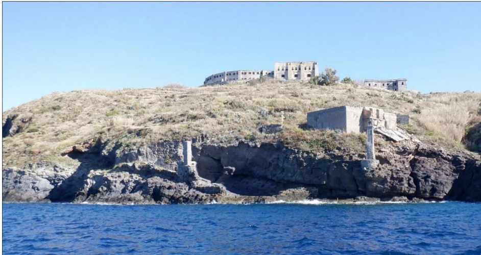
Figura 17 - Vista dal mare dell'area di approdo – ante operam
