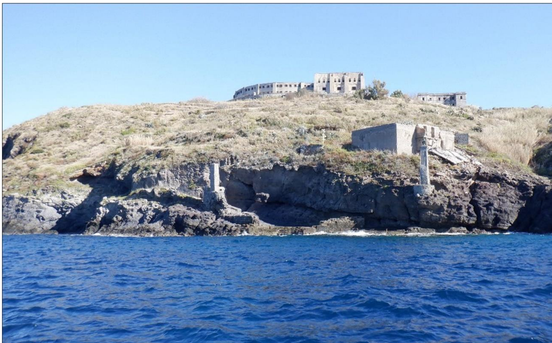
Figura 35 - Vista dal mare dell'area di approdo – ante operam
