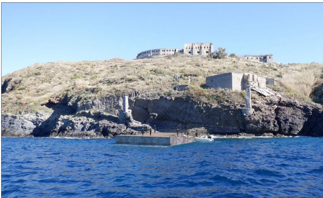
Figura 36 - Vista dal mare dell'area di approdo – post operam
