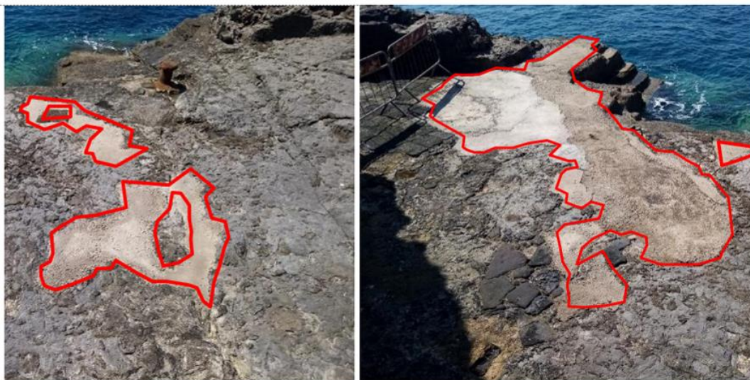
Figura 17. Eliminazione inserti in cls sulla scogliera
