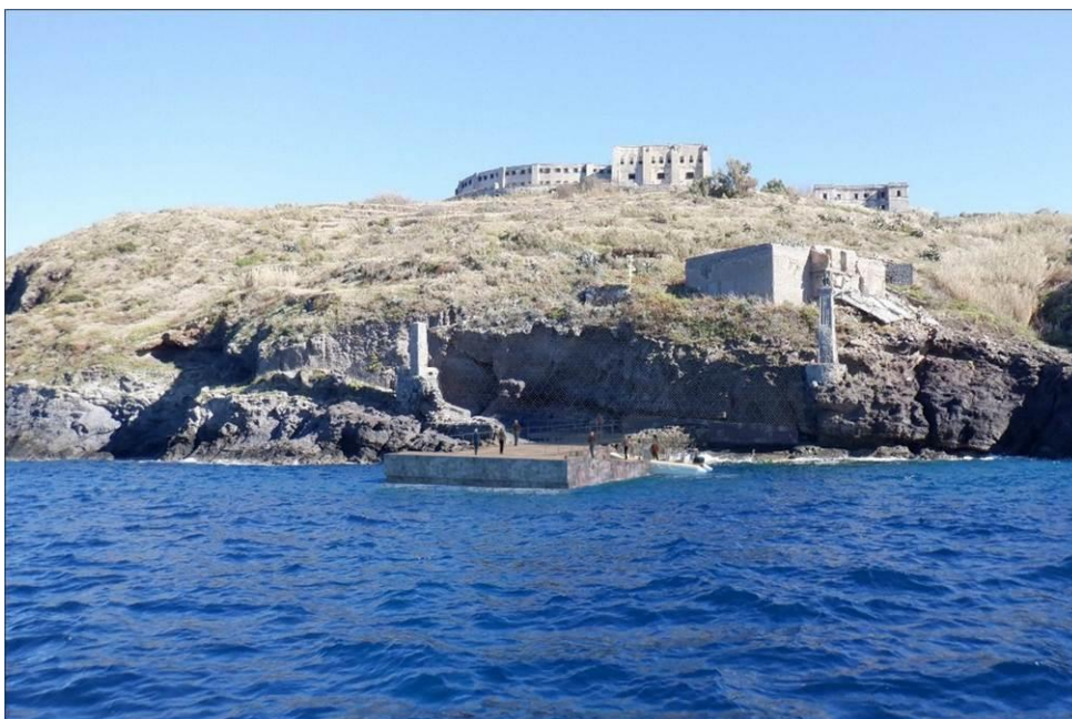
Figura 12. Vista da mare, condizione post operam
