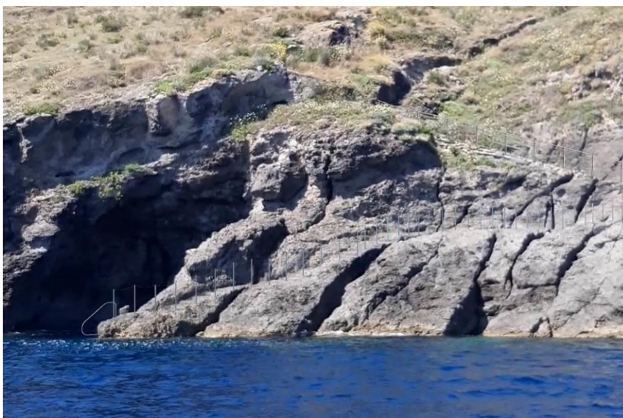
Figura 31. Vista da mare, condizione post operam
