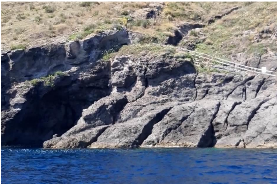
Figura 30. Vista da mare, condizione ante operam
