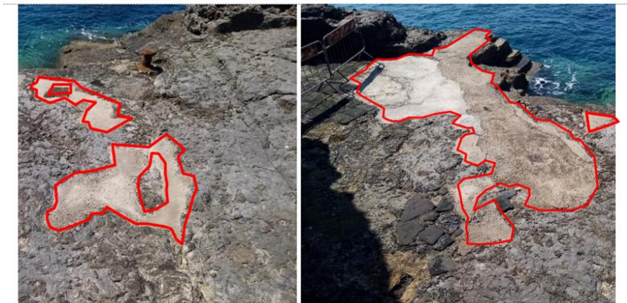
Figura 26. Eliminazione inserti in cls sulla scogliera
