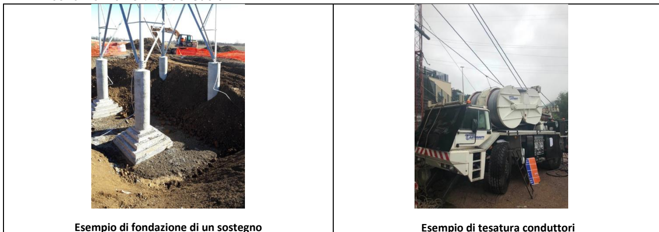
Figura 4.5: Costruzione degli elettrodotti aerei
