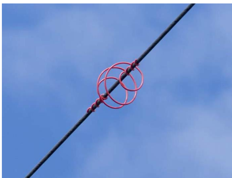
Figura 7.1: Spirale colorata in plastica per la segnalazione dei cavi.
