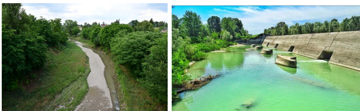
Figura 6.3: Il Torrente Crostolo (a sinistra) e le Casse di espansione del Fiume Secchia (a destra)
