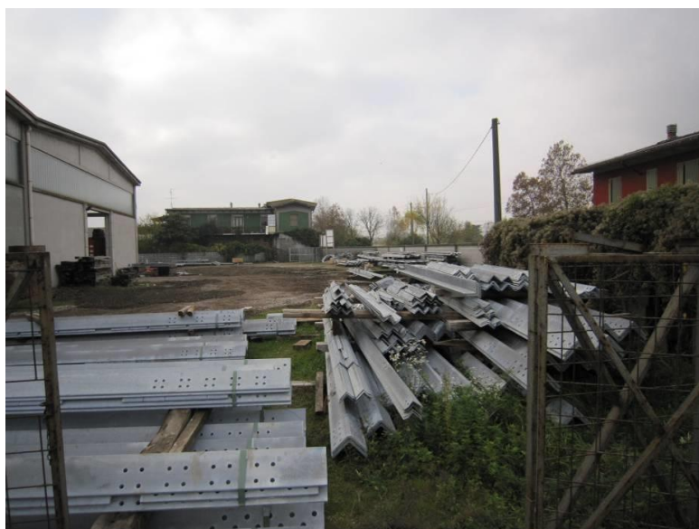
Figura 4.16: Cantiere base – esempio di deposito materiale
