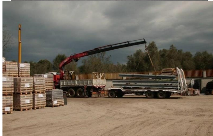
Figura 4.17: Cantiere base – esempio di mezzi utilizzati in fase di cantiere
