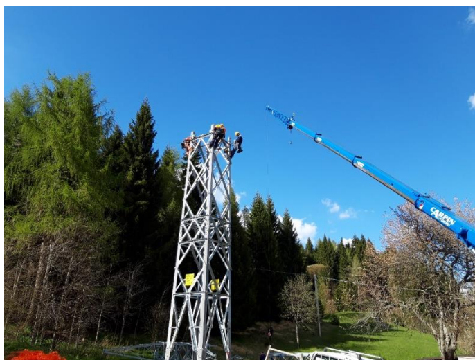
Figura 4.19: Esempio di montaggio sostegno con autogrù
