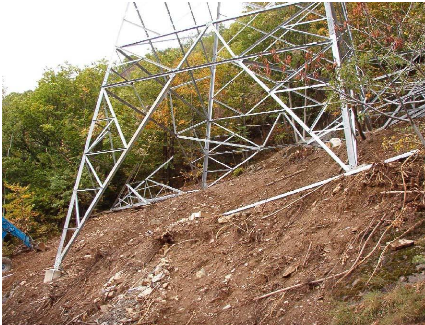
Figura 4.4: Esempio di configurazione a quattro piedi dei sostegni
