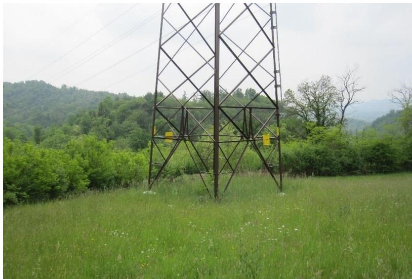
**Figura 7-3: Esempio del basamento di un traliccio**
