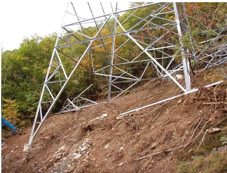
Figura 1 - Configurazione a quattro piedi dei sostegni
