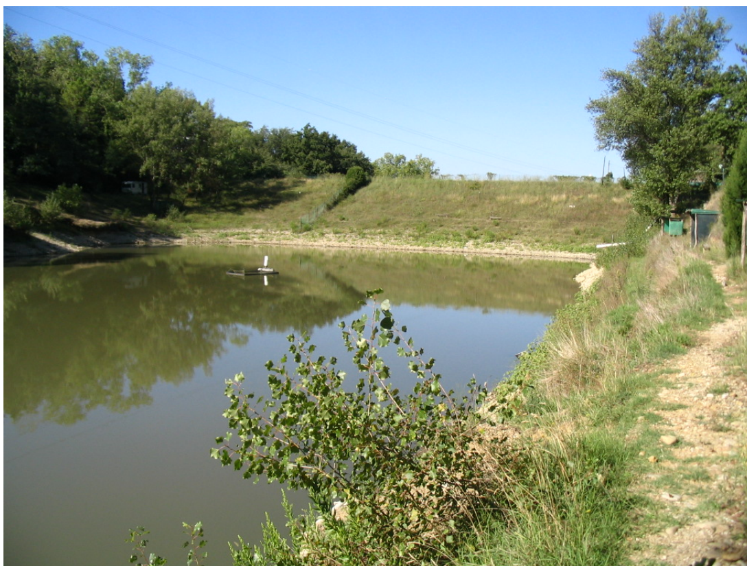
Figura 25 - Vista del paramento di monte
