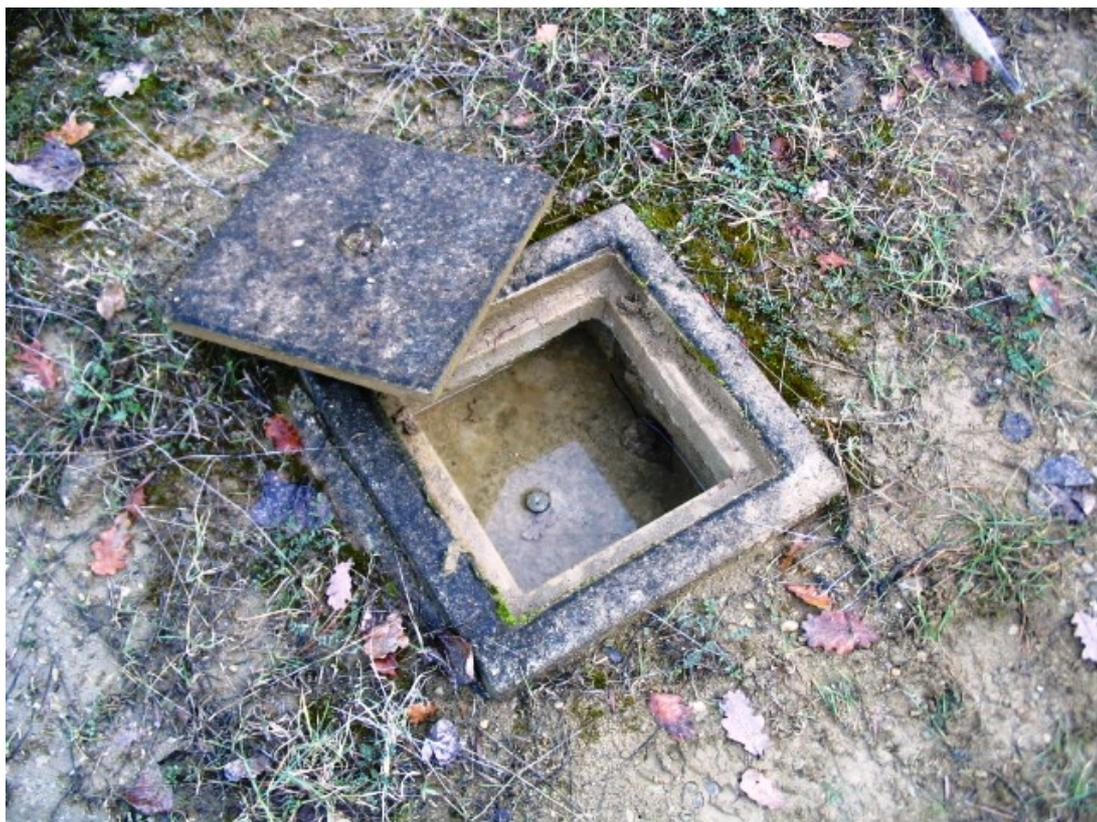
Fig. 15: altro pilastro di misura sul coronamento della diga
