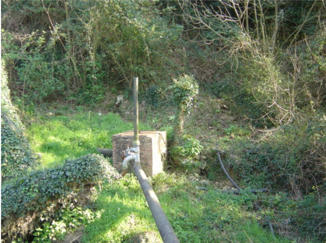
Fig. 13: pozzetto di manovra dello scarico di fondo della diga e tubazione di derivazione per fini irrigui
