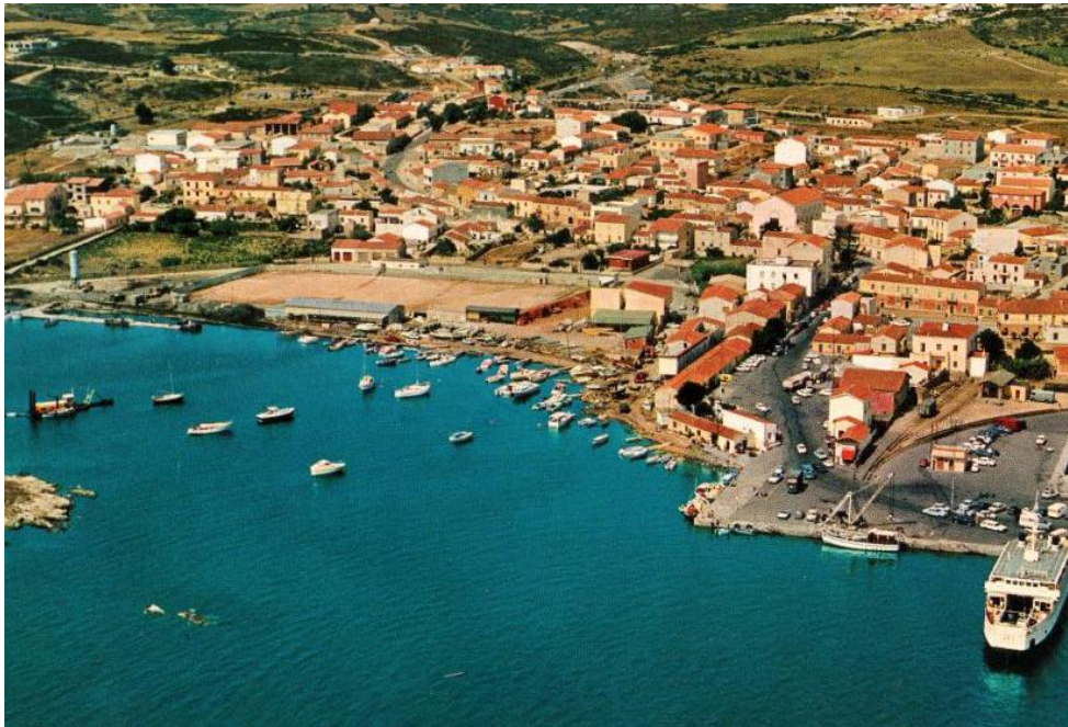
Foto 9: Sono appena iniziati i lavori per il porto turistico. Il traghetto ormeggia "di punta"
