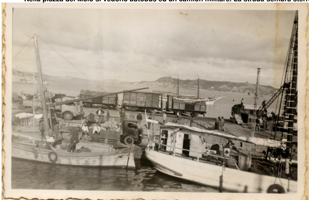
Foto 4: Ben visibile la gru usata per decenni. Visibile il basolato in granito
