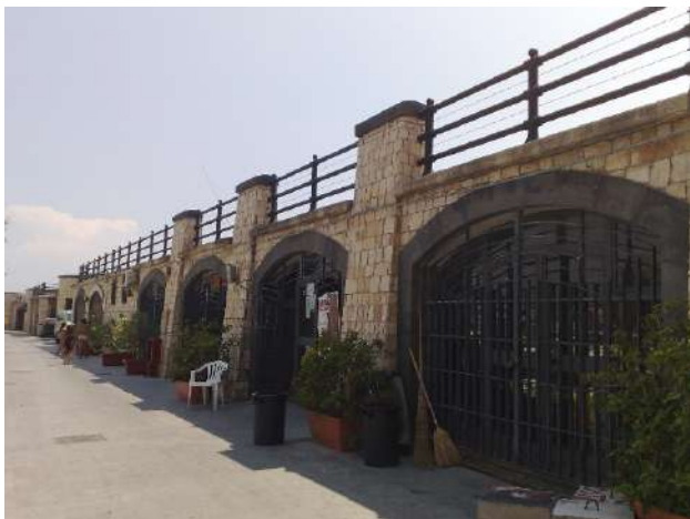
locali nella banchina del sopraflutto
