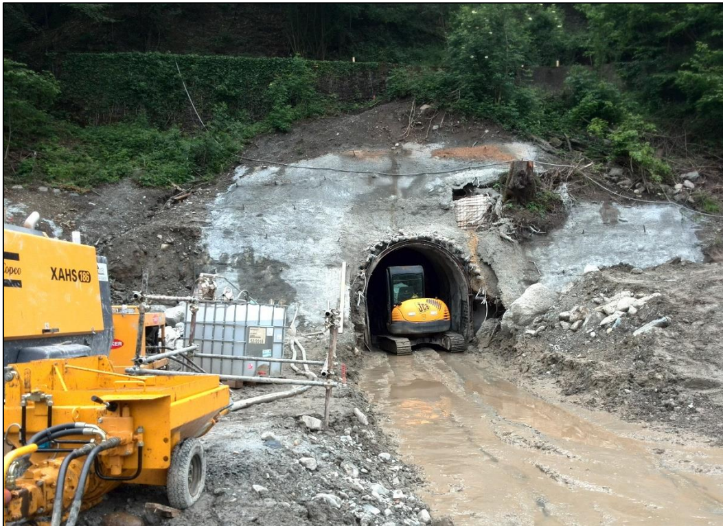
Fig. 2.11 - Galleria di base
