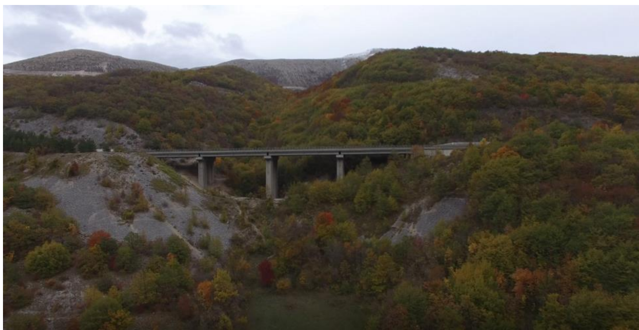
Fig.10 – Vista dell'attuale viadotto Vaccarini, a mezza costa del versante Le Conche
