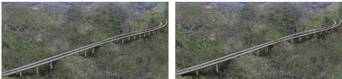
Figura 6 Estratto fotoinserimenti Viadotti di Lanzo secondo il PE 2017 (a sx) e la variante proposta a (dx)
