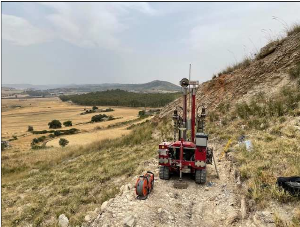
Figura 2 Foto DPSH sostegno 90-3
