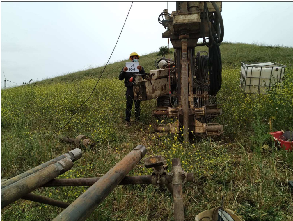
Figura 2 Foto sondaggio sostegno 90-7
