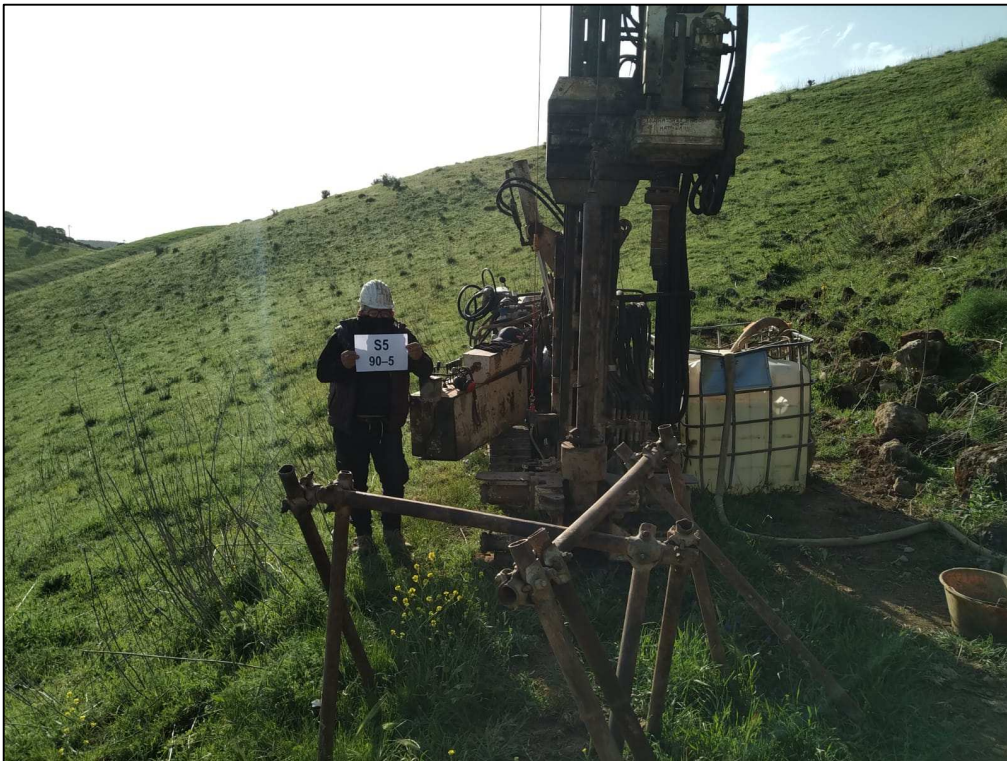
Figura 2 Foto sondaggio sostegno 90-5
