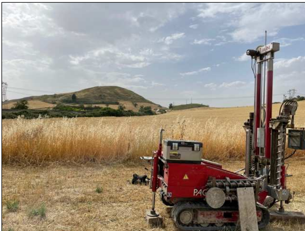
Figura 2 Foto DPSH sostegno 90-2
