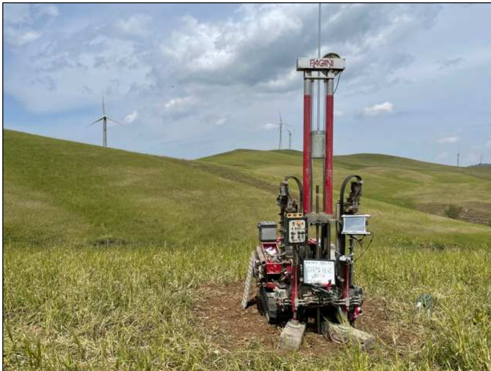
Figura 2 Foto DPSH sostegno 80-4
