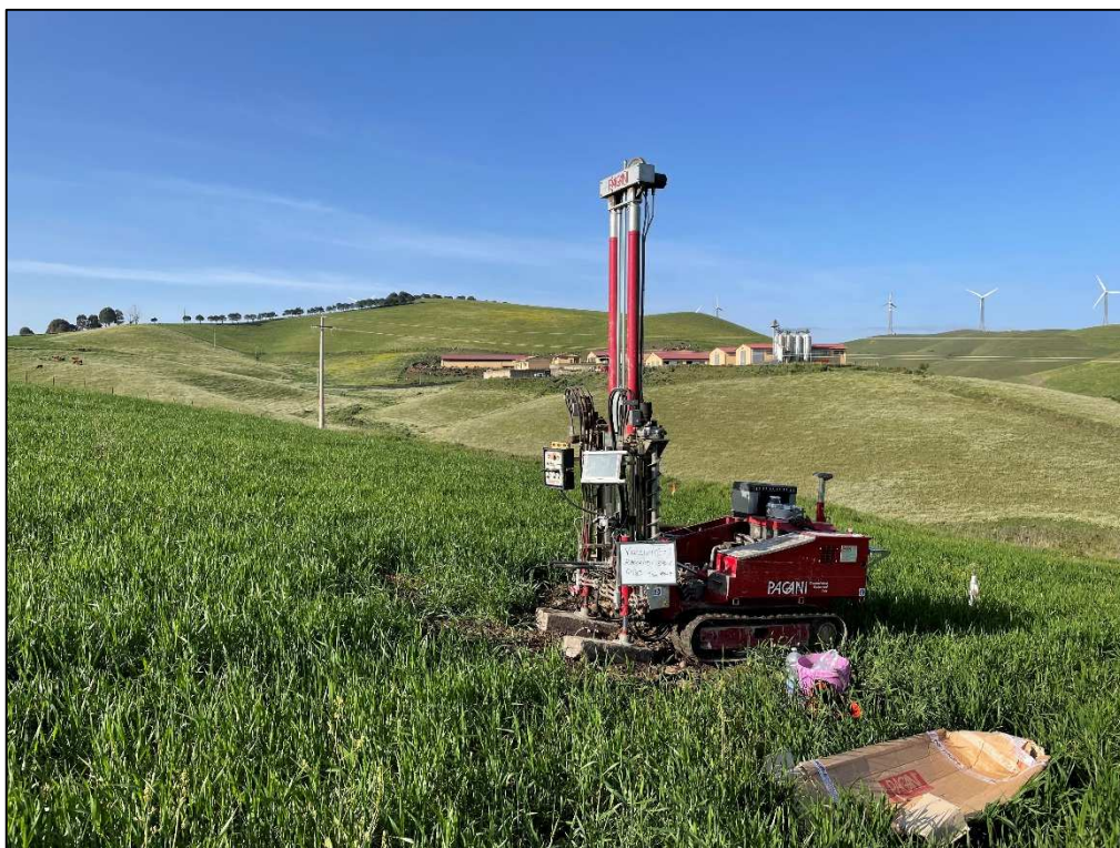
Figura 2 Foto DPSH sostegno 90-9
