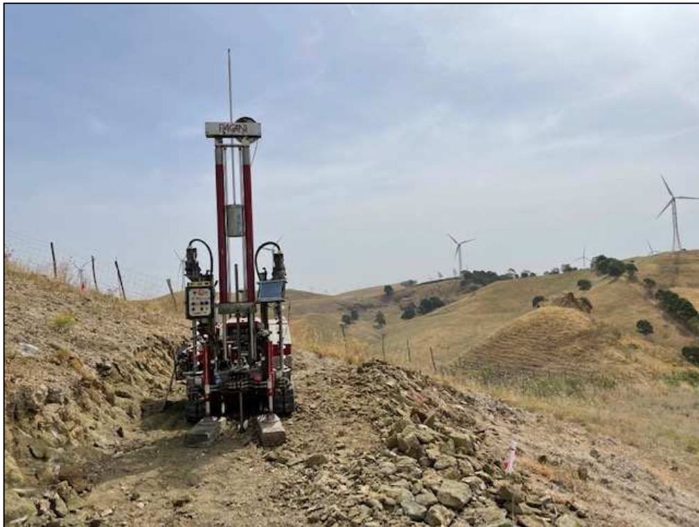
Figura 2 Foto DPSH sostegno 90-4
