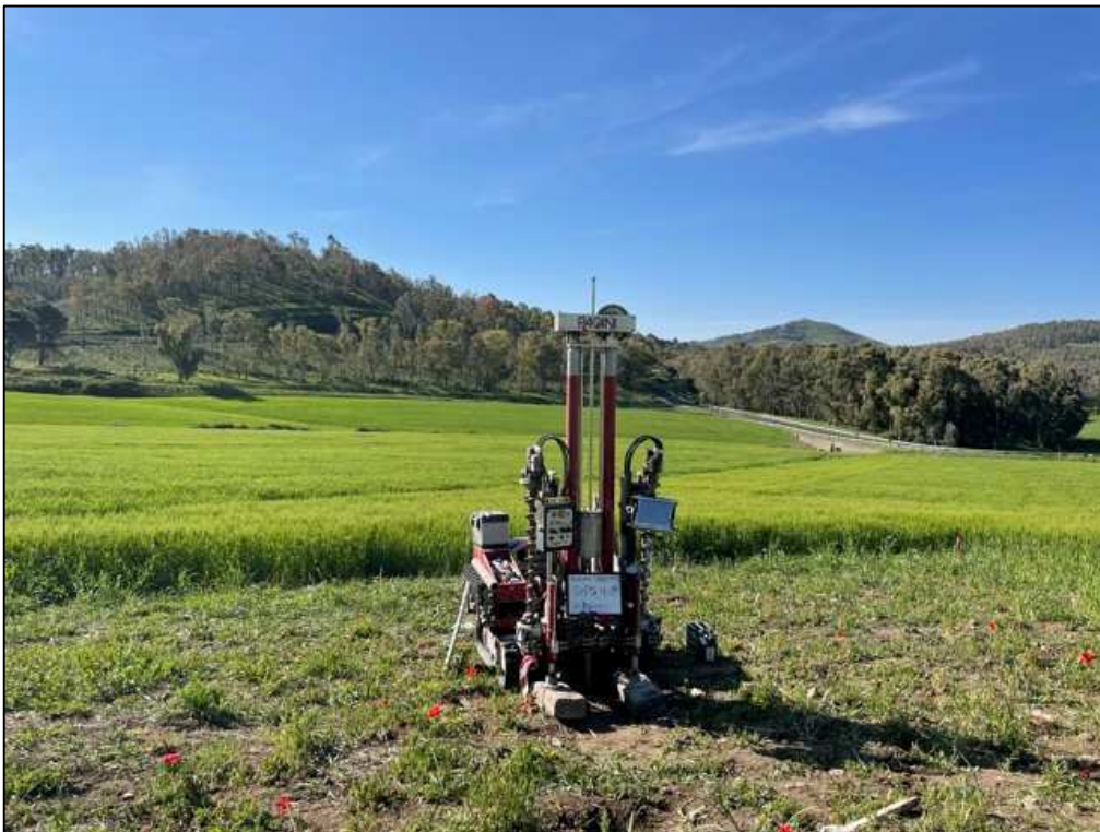
Figura 2 Foto DPSH sostegno 90-1
