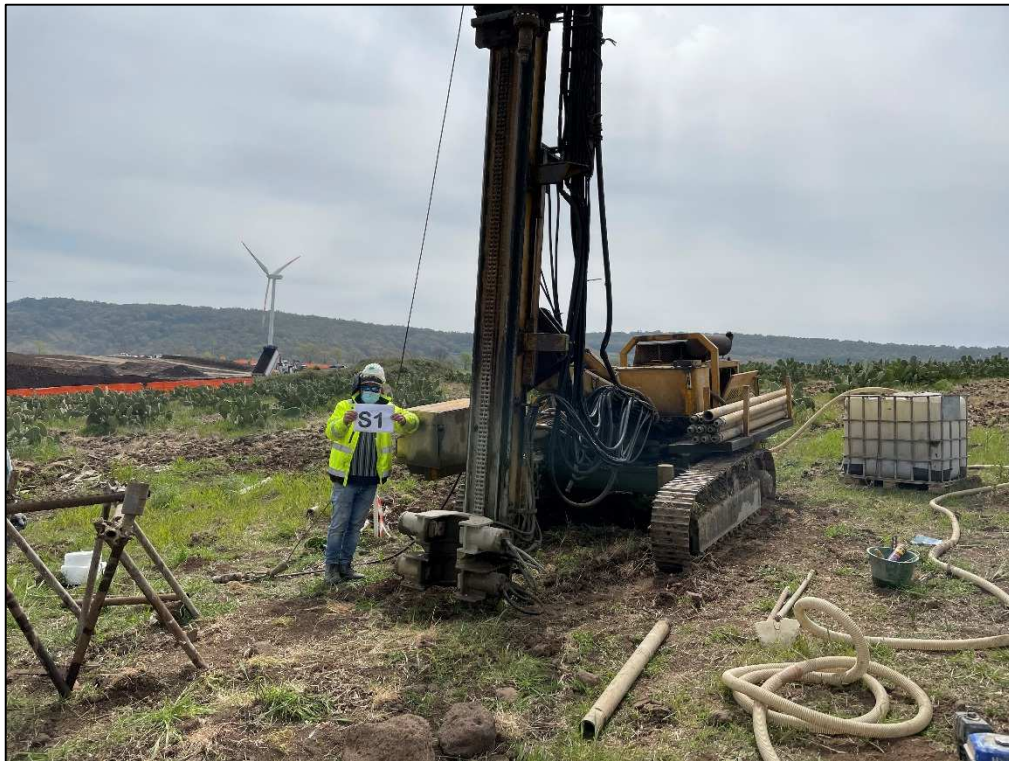
Figura 2 Foto sondaggio sostegno 80-6
