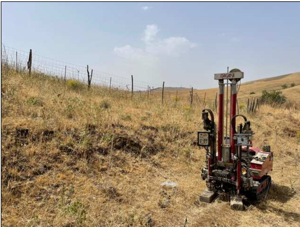
Figura 2 Foto DPSH sostegno 80-3
