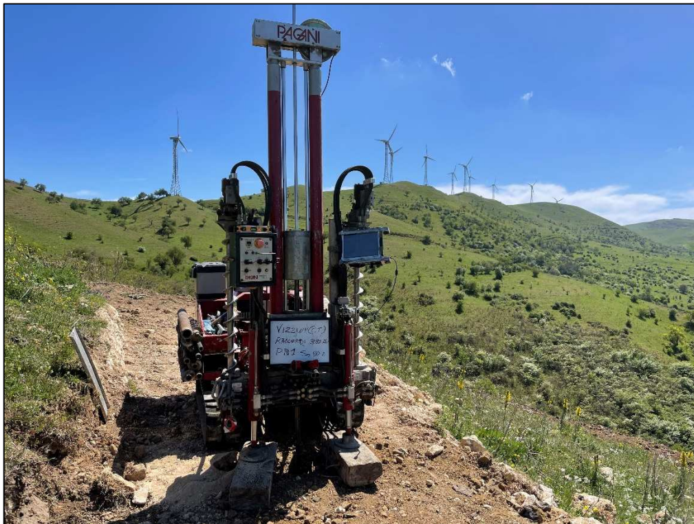
Figura 2 Foto DPSH sostegno 80-2
