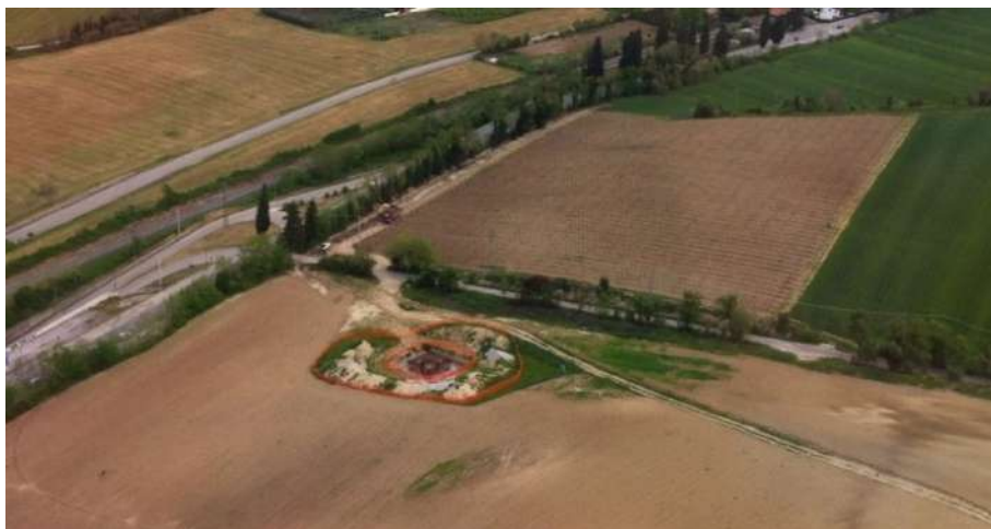
Area sostegno - vista dall'alto dell'estensione complessiva del micro-cantiere
