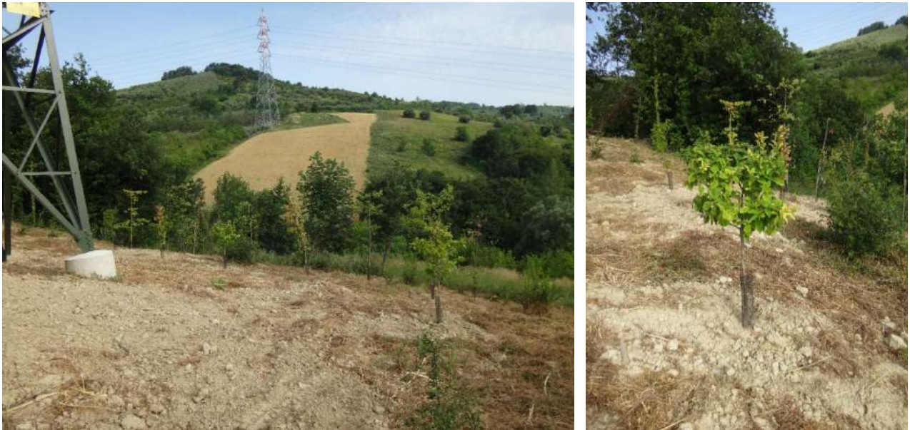
Esempio di ripristino di un microcantiere localizzato su un versante
