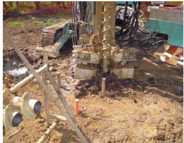
Esempio di realizzazione di una fondazione su micropali tipo tubfix.
