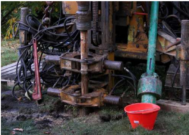
Esempio di realizzazione di una fondazione su micropali tipo tubfix.
