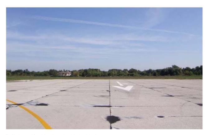
Fig. 51 - Lo stato di fatto della pavimentazione della pista di decollo
