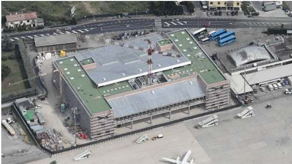
Lavori di costruzione dell' attuale Terminal passeggeri (2006).
