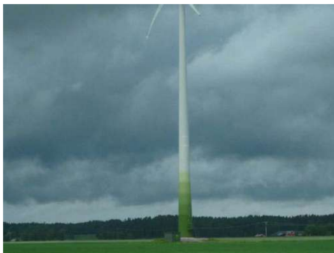
Figura 9-2: Esempio di gradazione cromatica alla base del palo.
