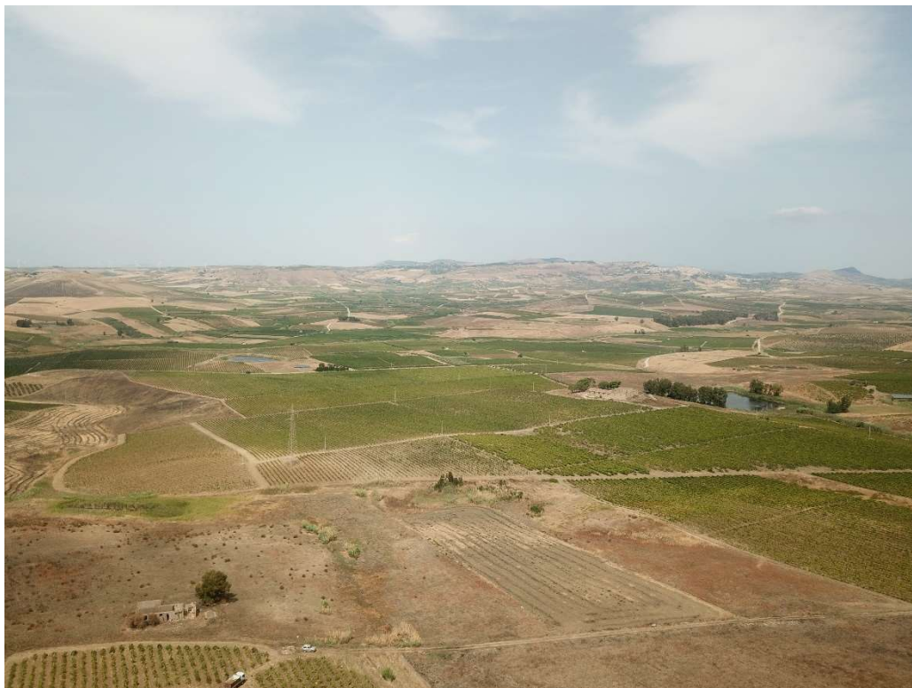
Punto di ripresa n.1 – Area su cui sorgerà la SSE di condivisione – ante operam
