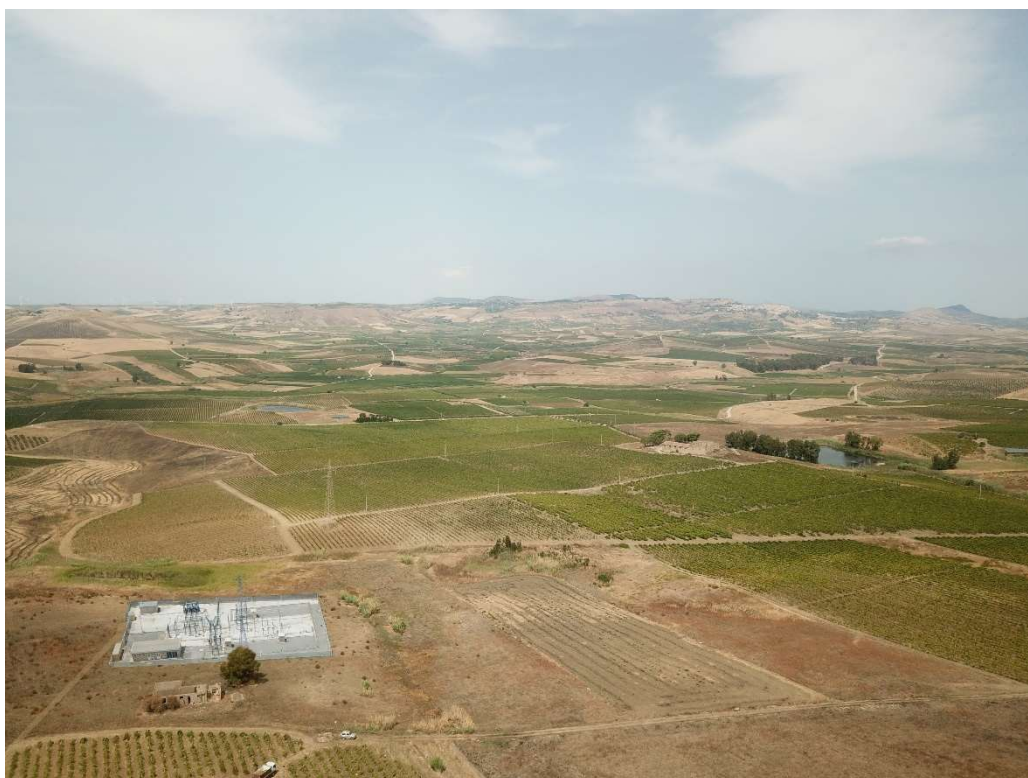
Punto di ripresa n.1 – Area su cui sorgerà la SSE di condivisione – post operam
