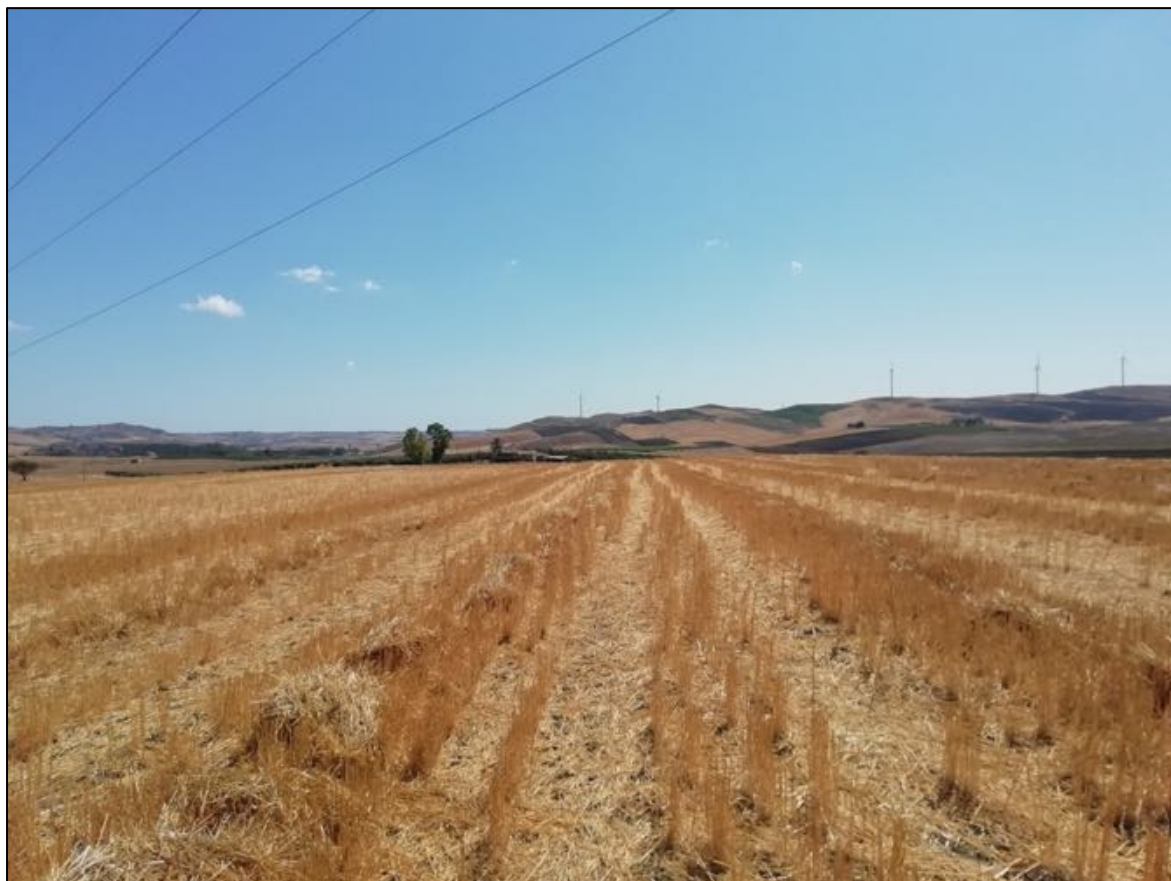
Foto 134: UR 56 (sostegno S20). Vista da nord verso sud.
