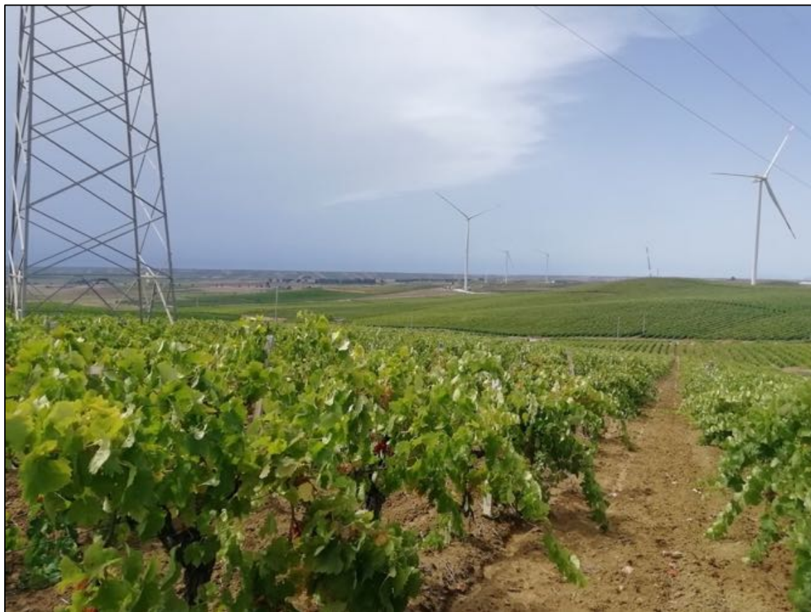
Foto 103: UR 41 (sostegno S5). Vista da est verso ovest.
