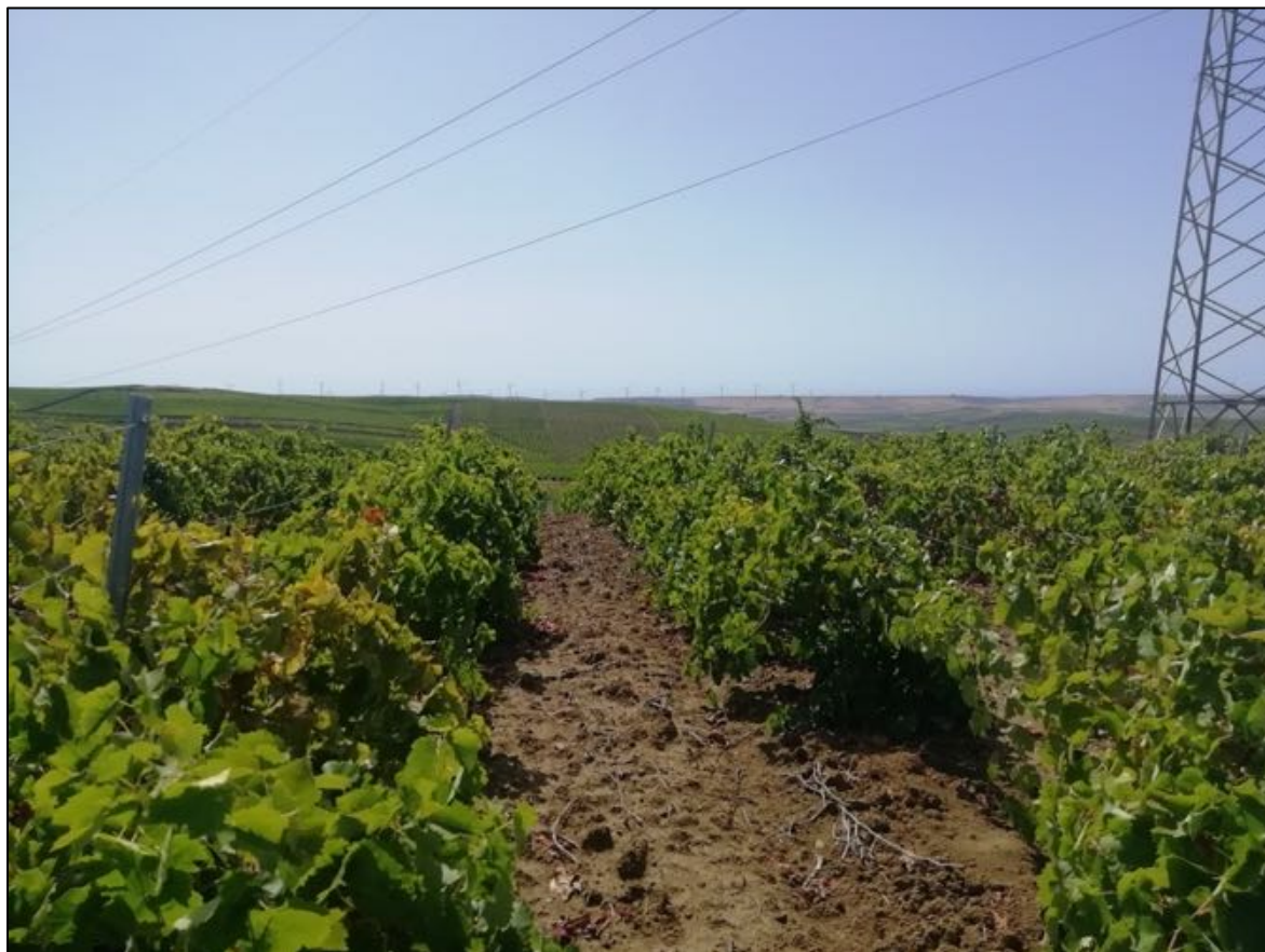
Foto 109: UR 44 (sostegno S8). Vista da nord verso sud.
