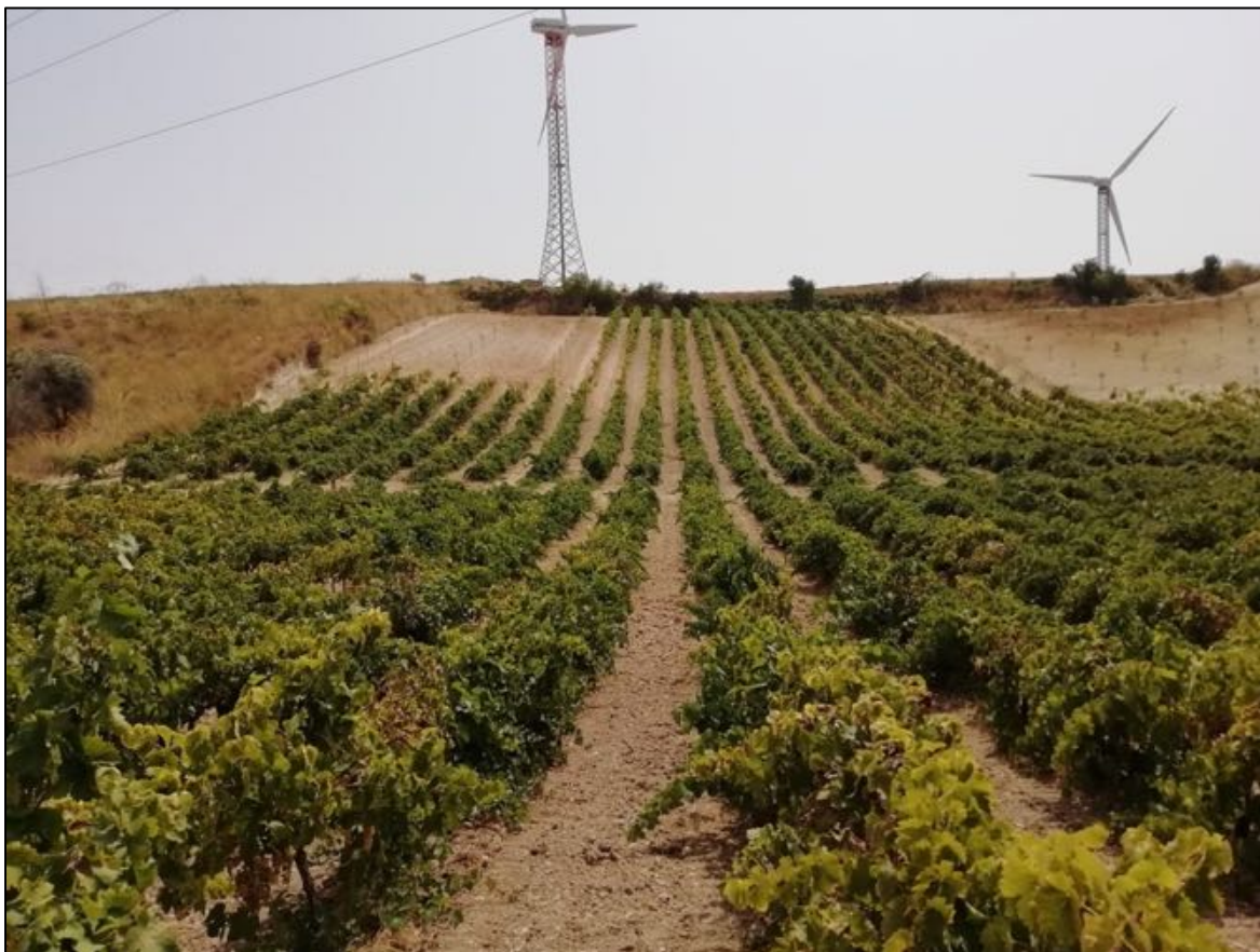
Foto 177: Panoramica UR 72 (sostegno 8). Vista da nord verso sud.
