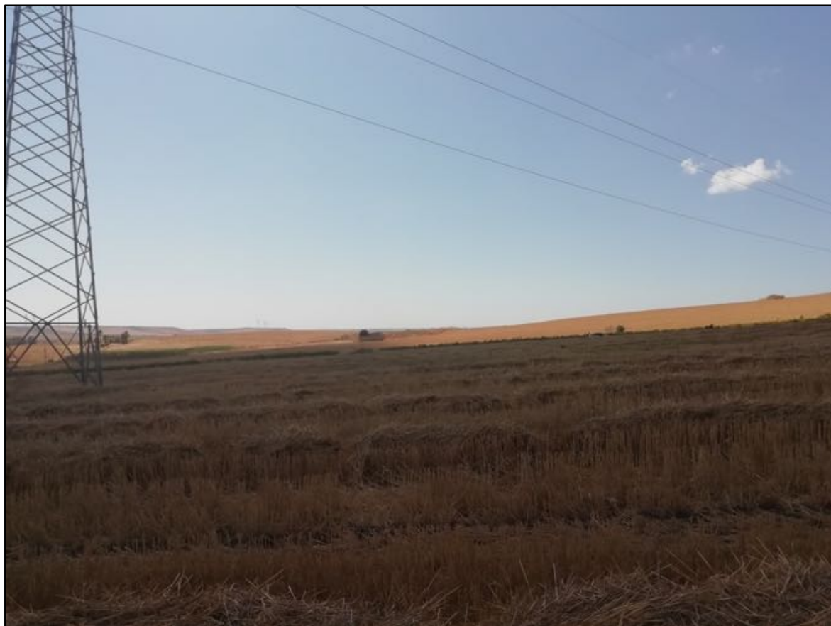
Foto 133: UR 55 (sostegno S19). Vista da est verso ovest.
