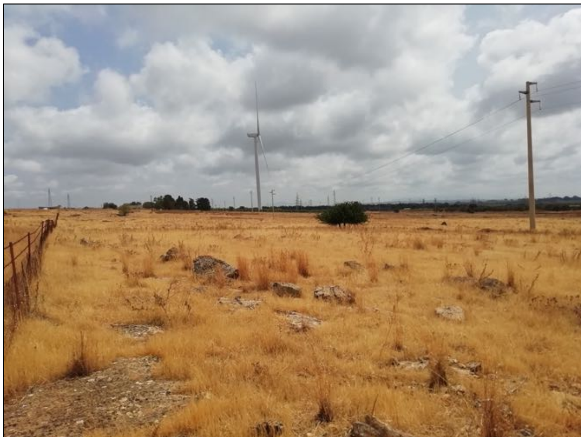
Foto 204: Panoramica UR 83 (sostegno 19). Vista da ovest verso est.
