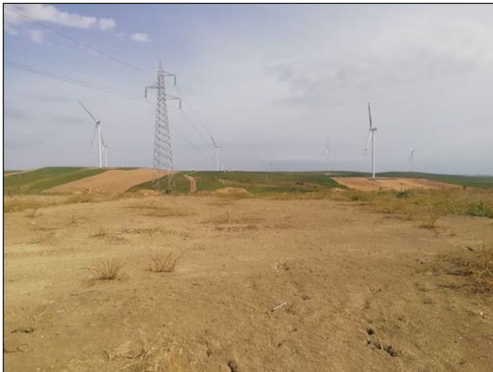
Foto 97 24 : Panoramica UR 38 (sostegni S1 e S2). Vista da nord-ovest verso sud-est.
