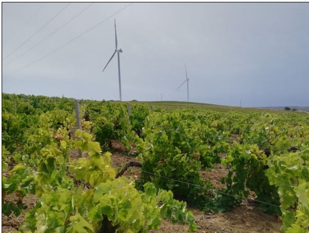
Foto 102: UR 41 (sostegno S5). Vista da nord verso sud.
