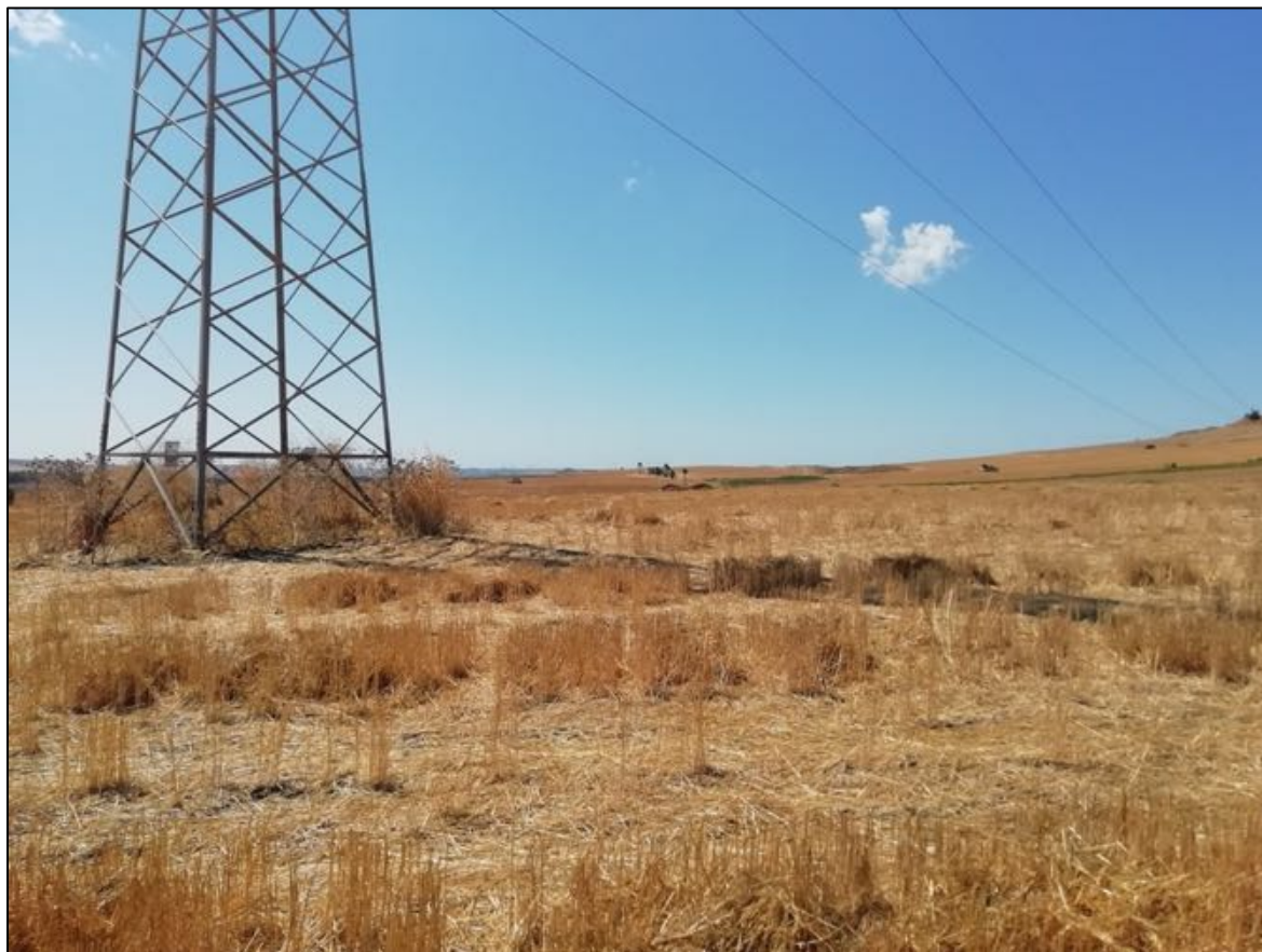
Foto 135: UR 56 (sostegno S20). Vista da est verso ovest.
