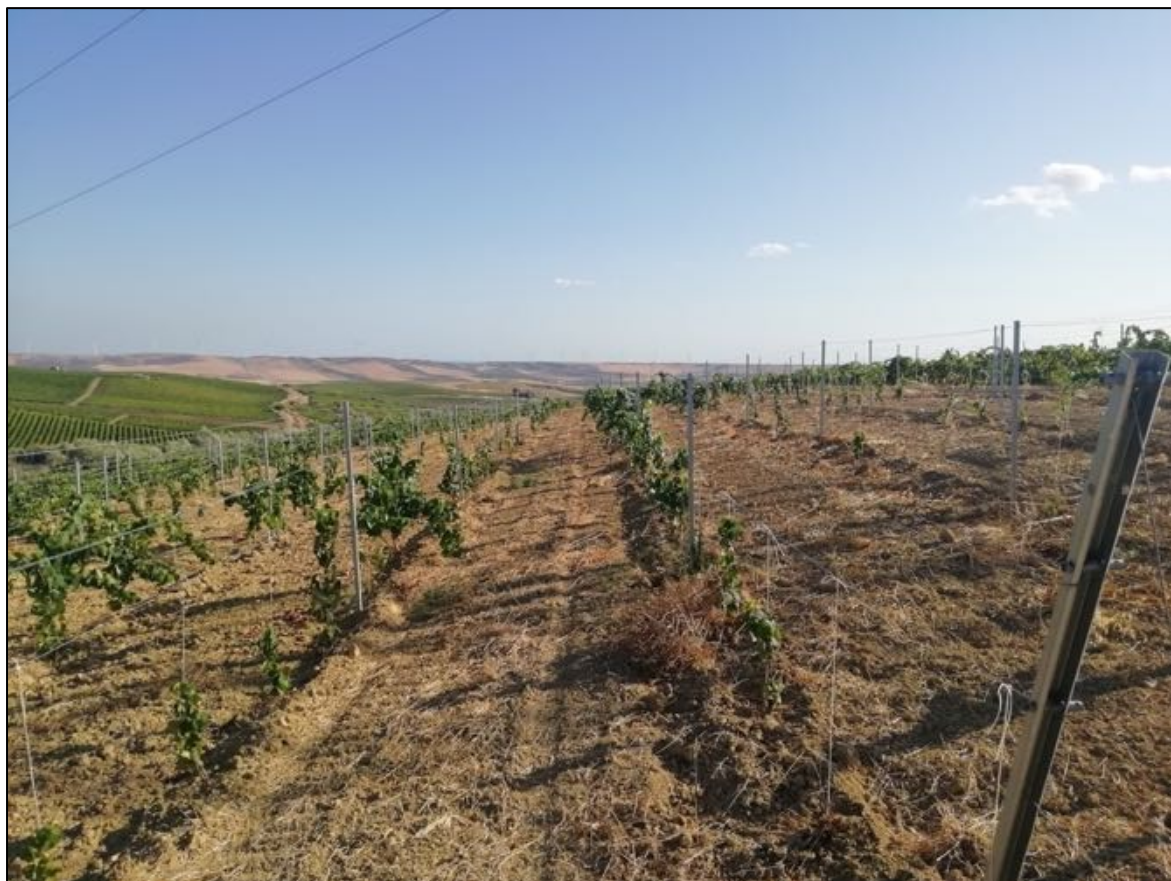
Foto 114: UR 46 (sostegno S10). Vista da nord verso sud.
