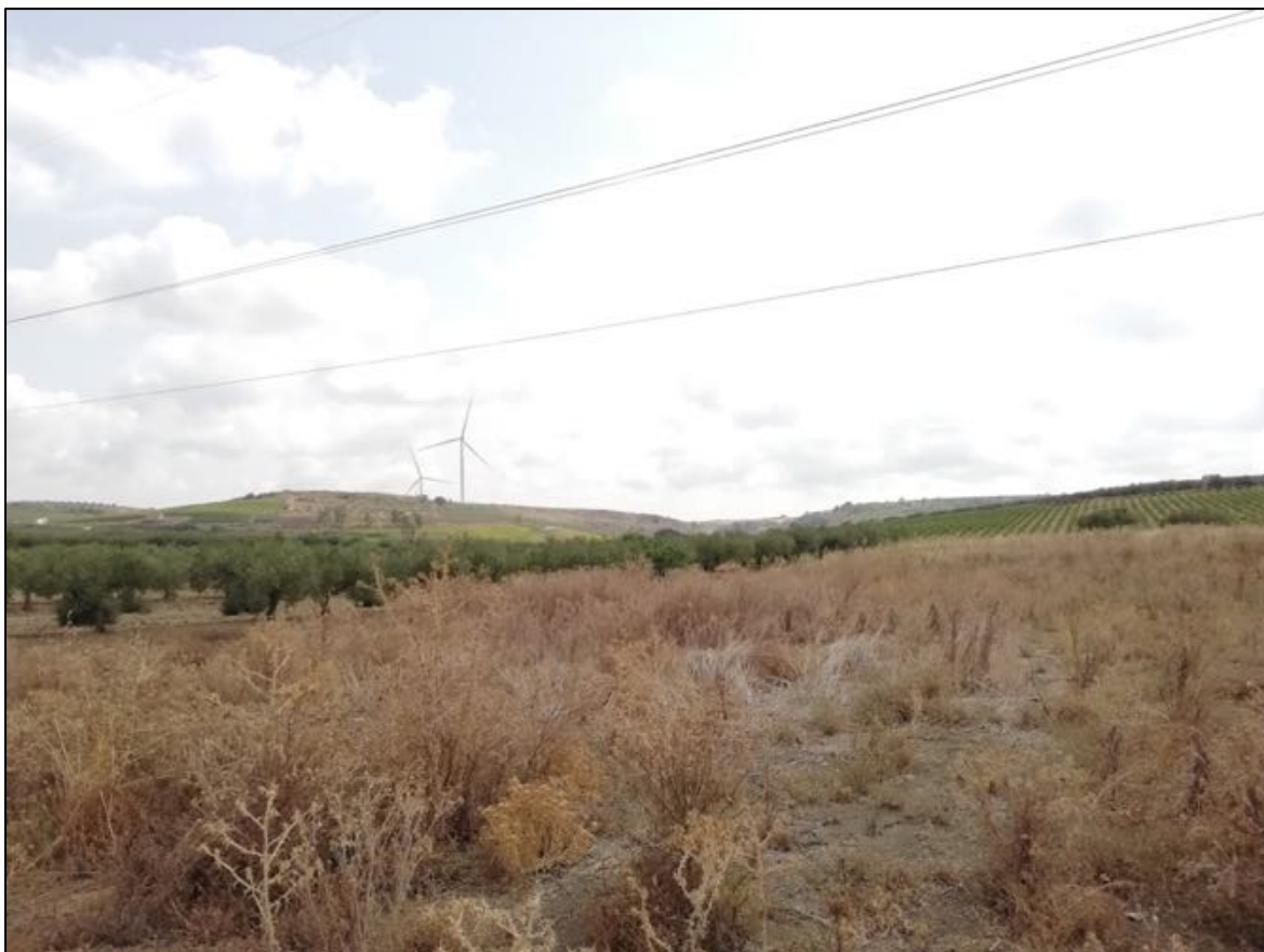
Foto 194: Panoramica UR 78 (sostegni 14 e 15). Vista da nord verso sud.
