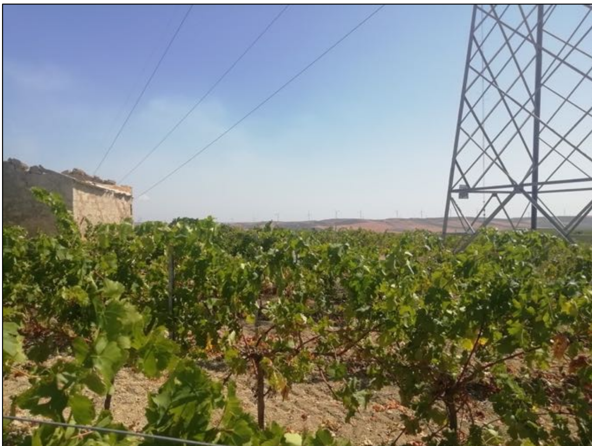
Foto 118: UR 48 (sostegno S11). Vista da nord verso sud.
