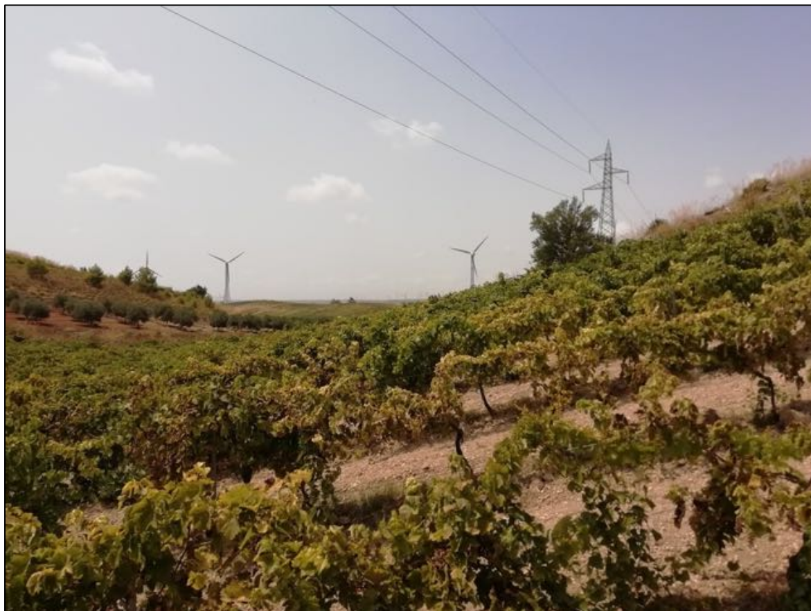
Foto 171: Panoramica UR 70 (sostegno 6). Vista da est verso ovest.
