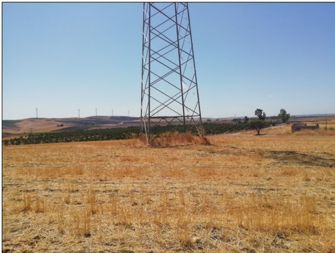
Foto 137: UR 57 (sostegno S21). Vista da est verso ovest.
