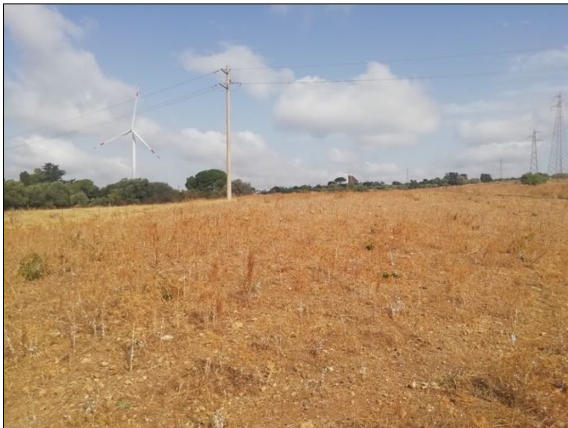
Foto 214: Panoramica UR 85 (sostegno 21). Vista da sud-est verso nord-ovest.
