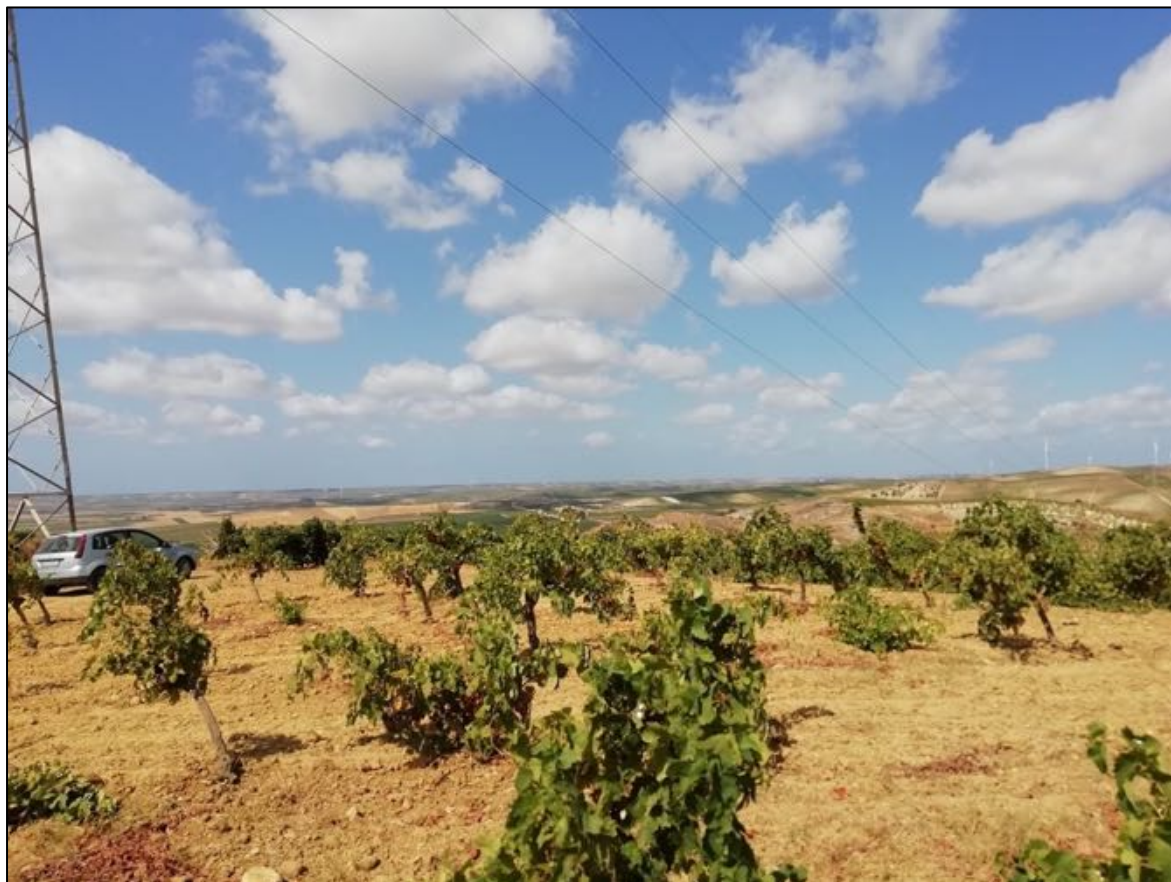
Foto 129: UR 53 (sostegno S17). Vista da est verso ovest.
