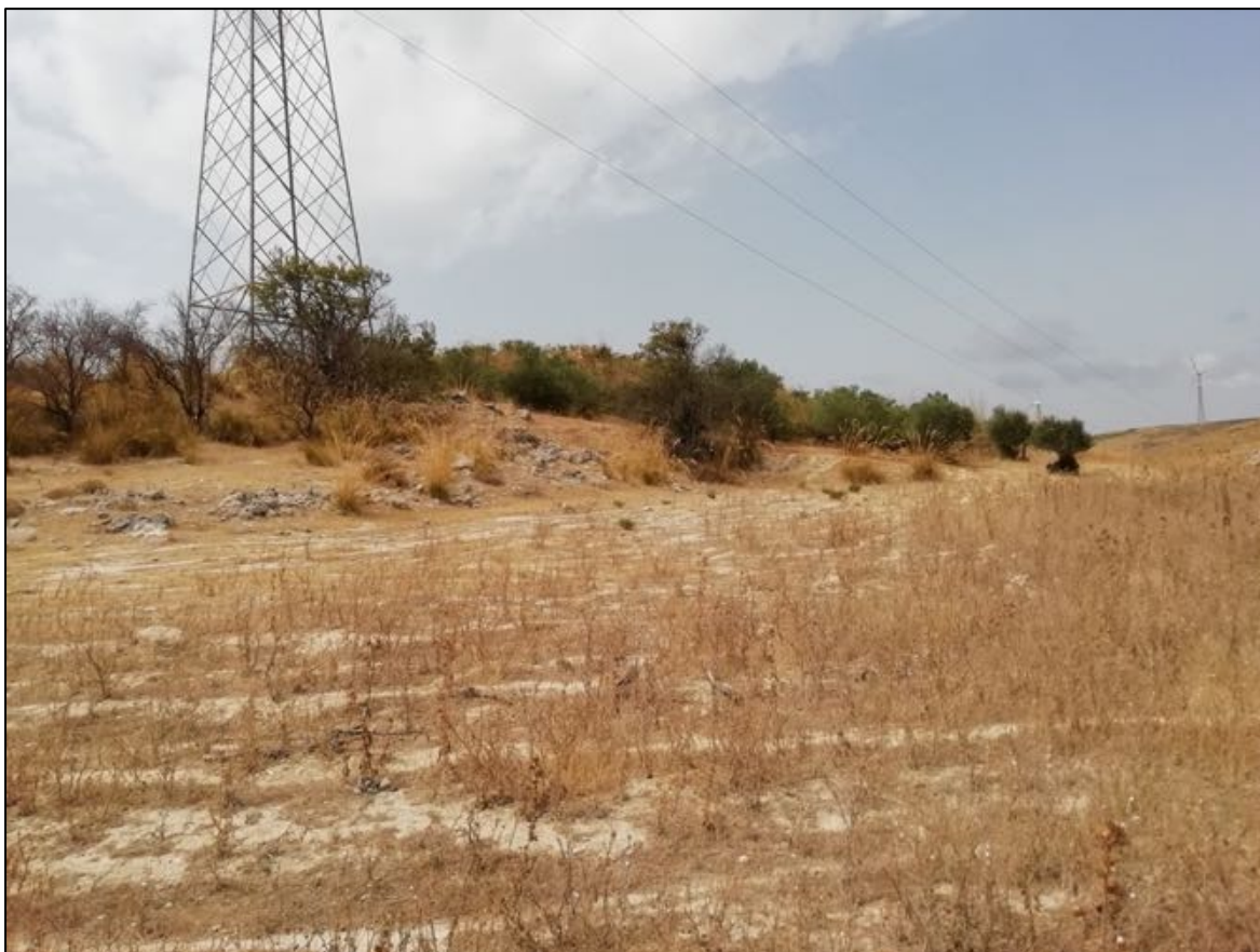
Foto 178: Panoramica UR 72 (sostegno 8). Vista da sud-est verso nord-ovest.
