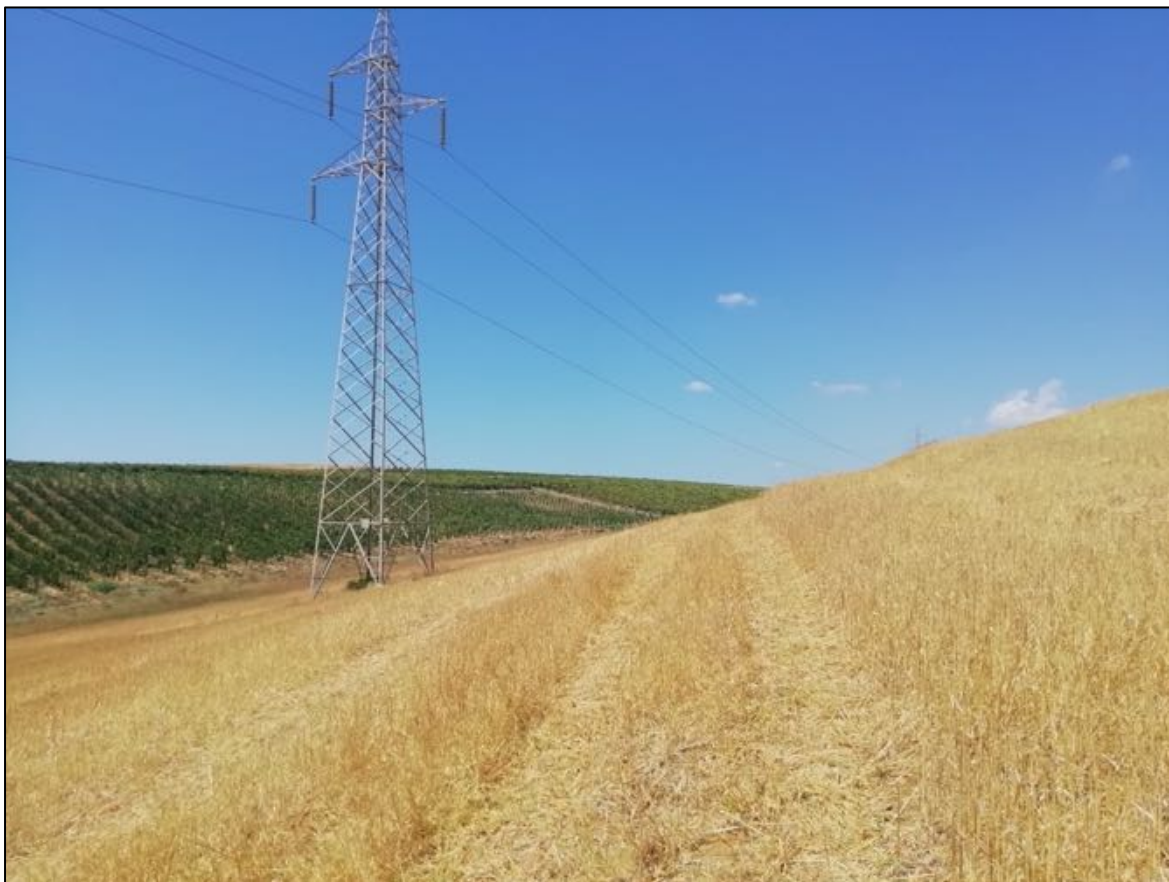
Foto 143: UR 60 (sostegno S24). Vista da est verso ovest.
