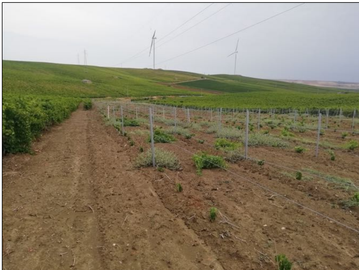
Foto 100: UR 40 (sostegno S4). Vista da nord verso sud.
