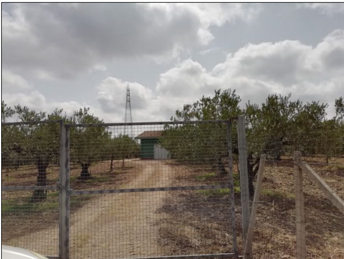
Foto 196: Panoramica UR 79 (sostegni 60 e 60 bis). Vista da nord-est verso sud-ovest.
