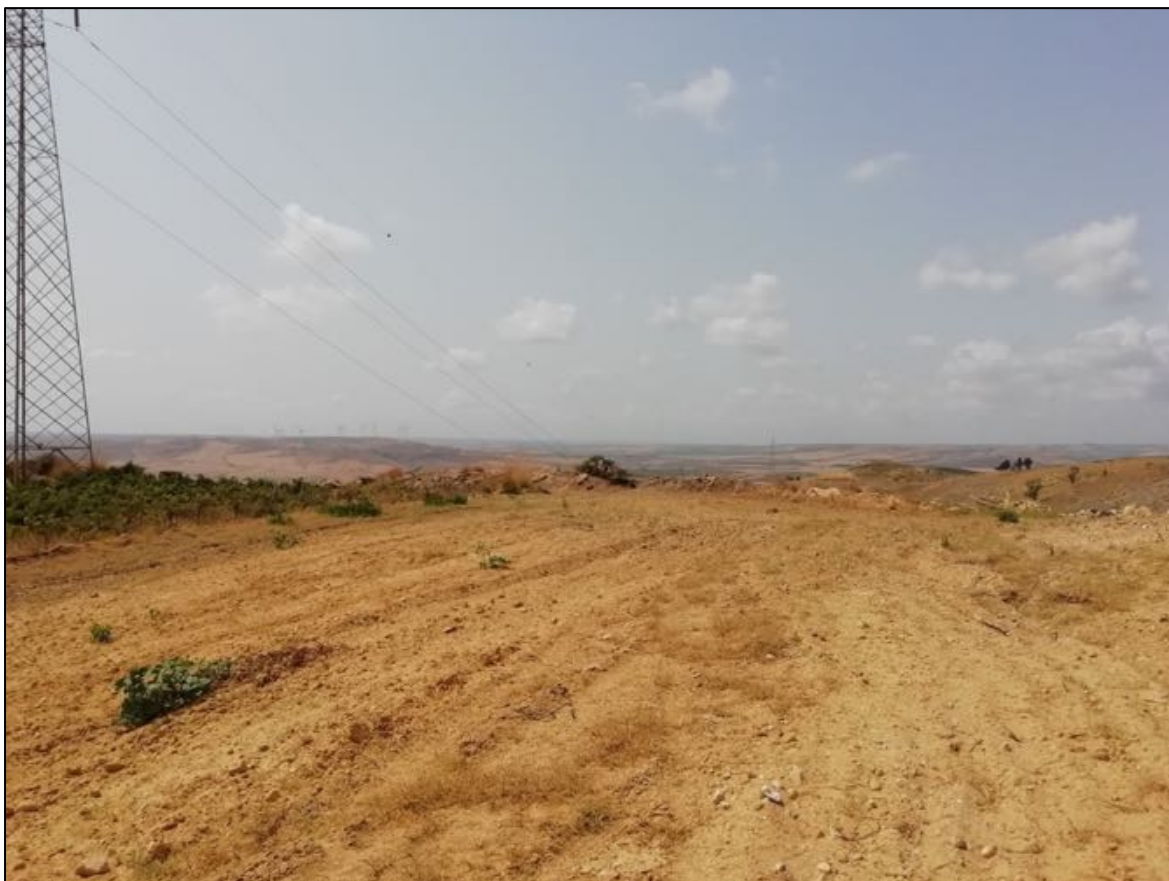
Foto 168: Panoramica UR 69 (sostegno 5) Vista da est verso ovest.
