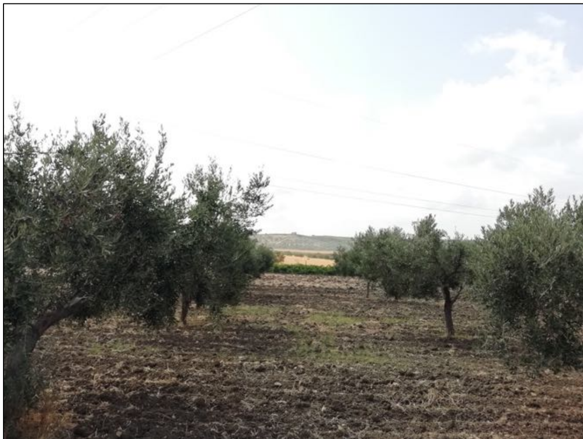
Foto 183: Panoramica UR 74 (sostegno 10). Vista da nord verso sud.
