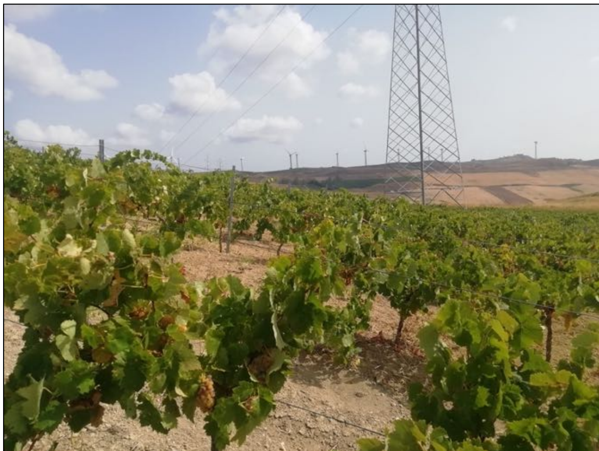
Foto 162: UR 67 (sostegno 3). Vista da est verso ovest.
