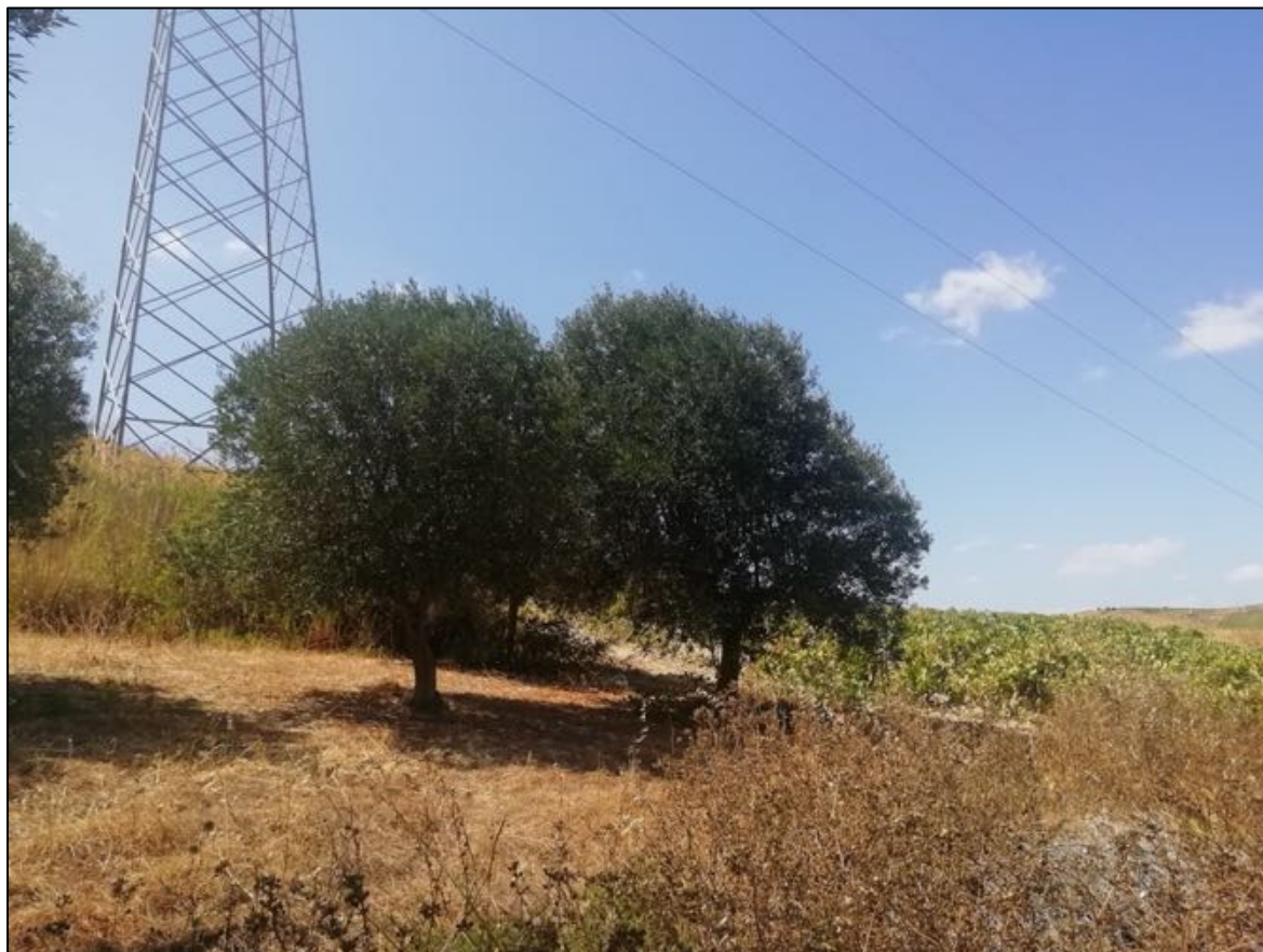
Foto 125: UR 51 (sostegno S15). Vista da est verso ovest.
