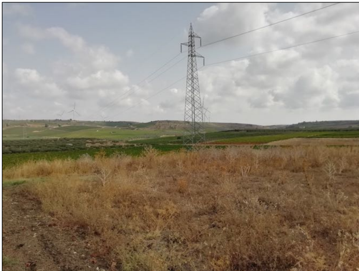
Foto 191: Panoramica UR 77 (sostegno 13). Vista da nord verso sud.
