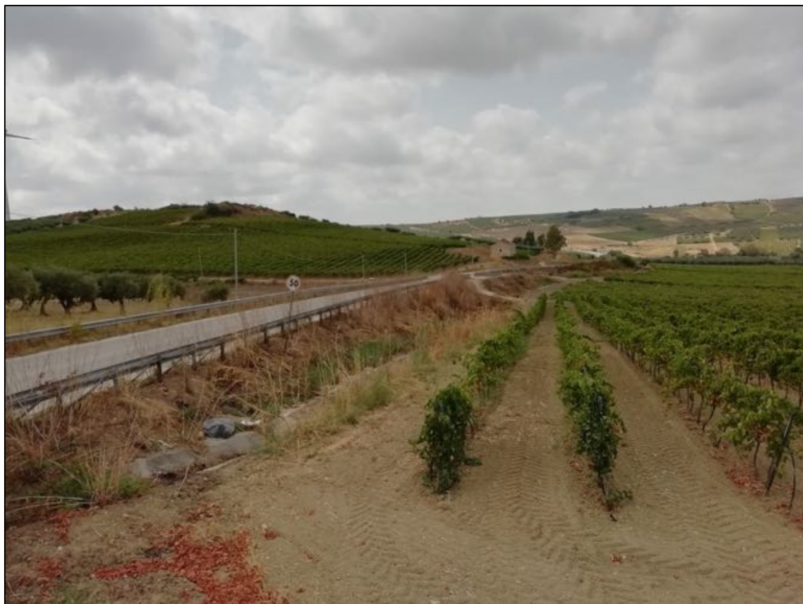
Foto 200: Panoramica UR 81 (sostegno 17). Vista da est verso ovest.
