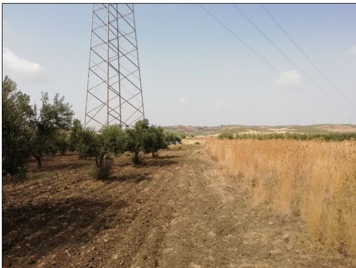
Foto 184: Panoramica UR 74 (sostegno) 10. Vista da est verso ovest.
