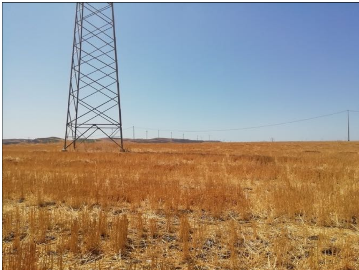
Foto 139: UR 58 (sostegno S22). Vista da est verso ovest.
