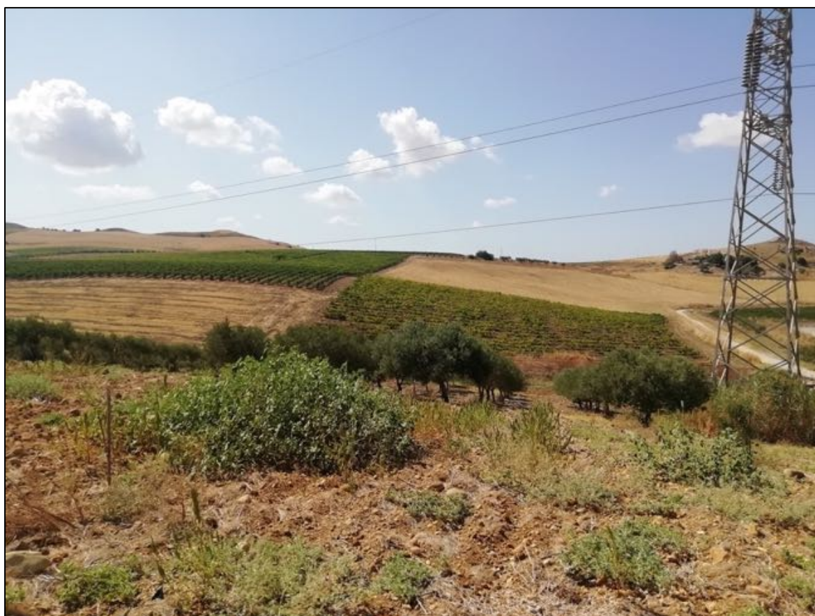
Foto 148: UR 62 (sostegno S26). Vista da nord verso sud.
