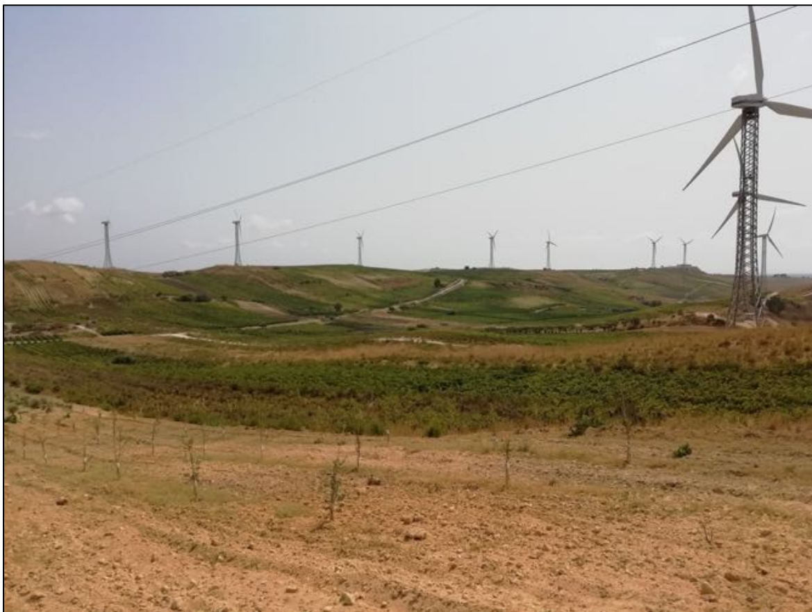
Foto 167: Panoramica UR 69 (sostegno 5). Vista da nord verso sud.
