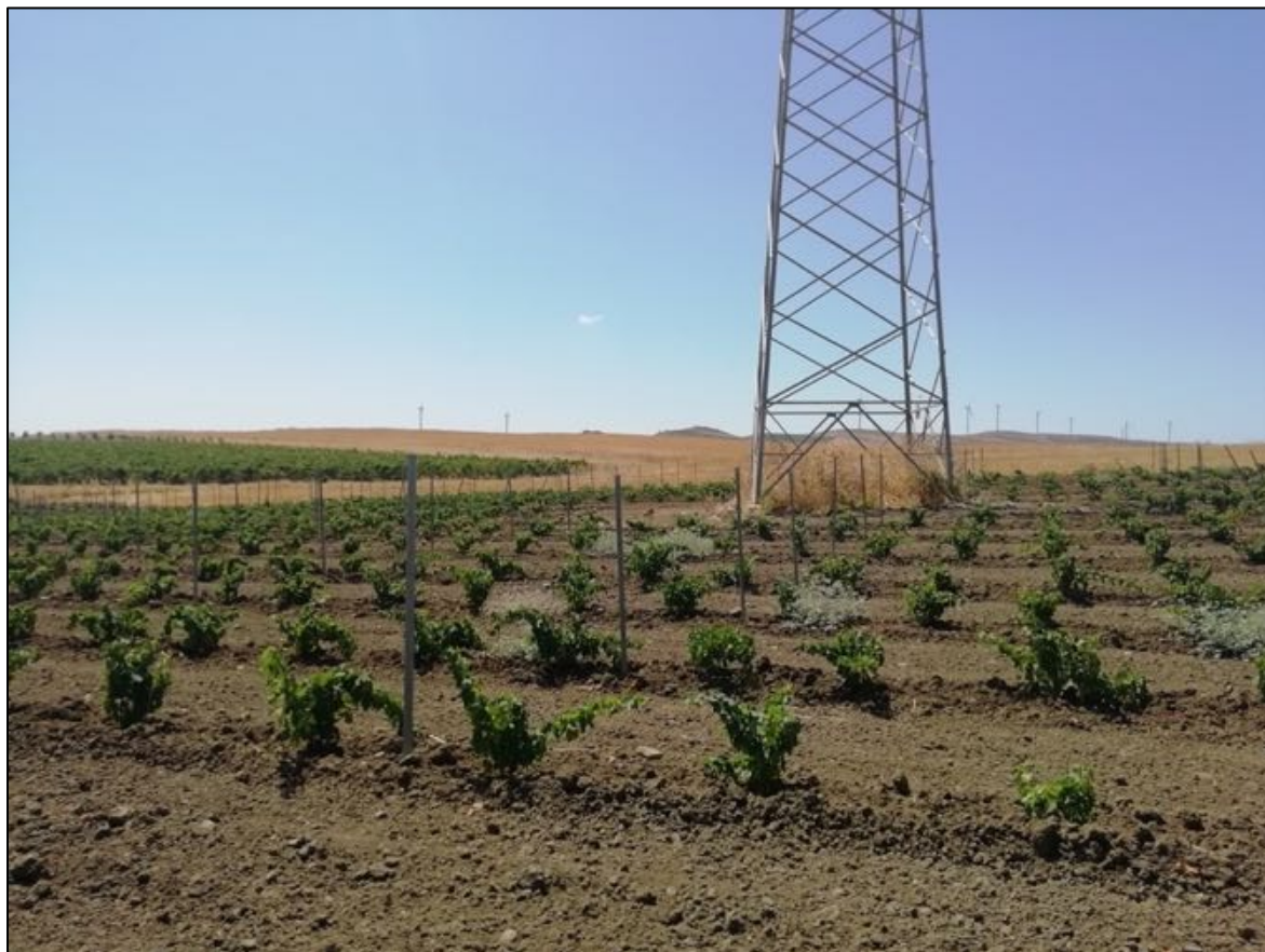
Foto 141: UR 59 (sostegno S23). Vista da nord verso sud.
