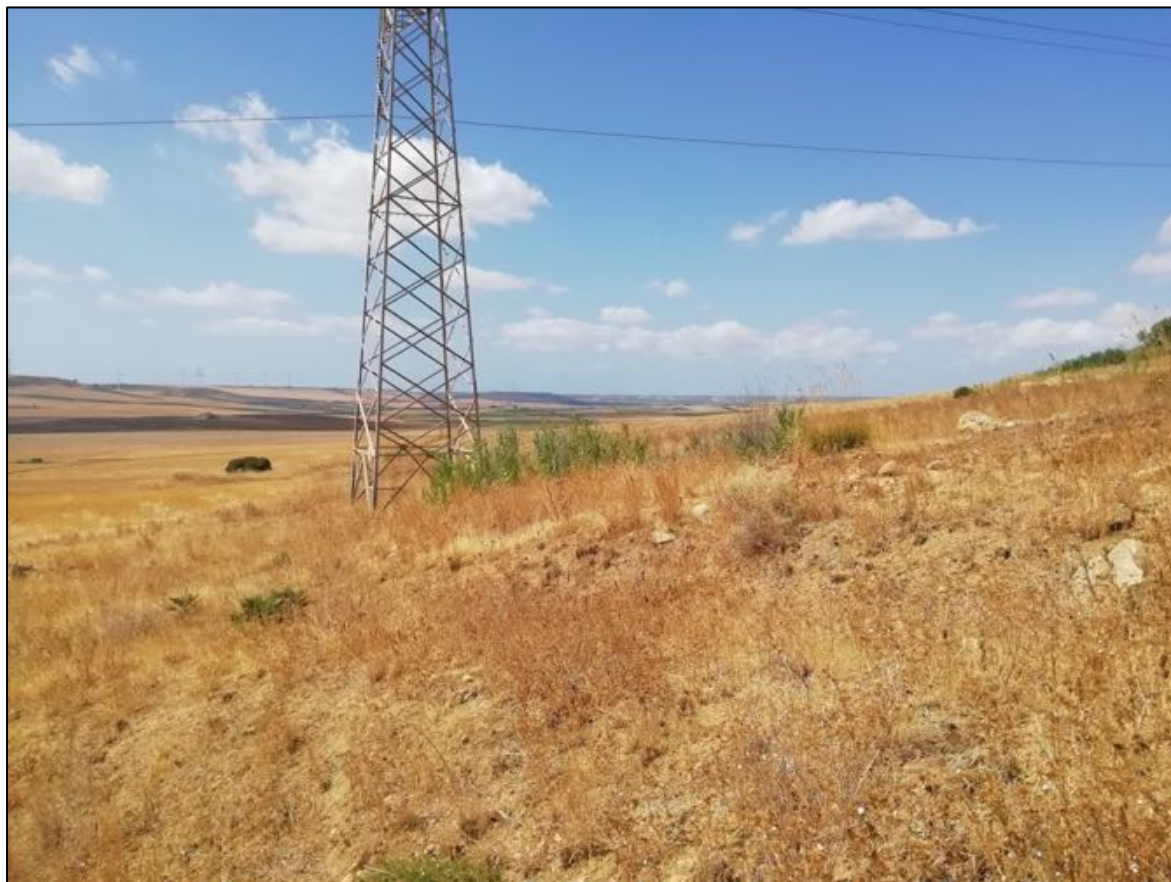
Foto 131: UR 54 (sostegno S18). Vista da est verso ovest.
