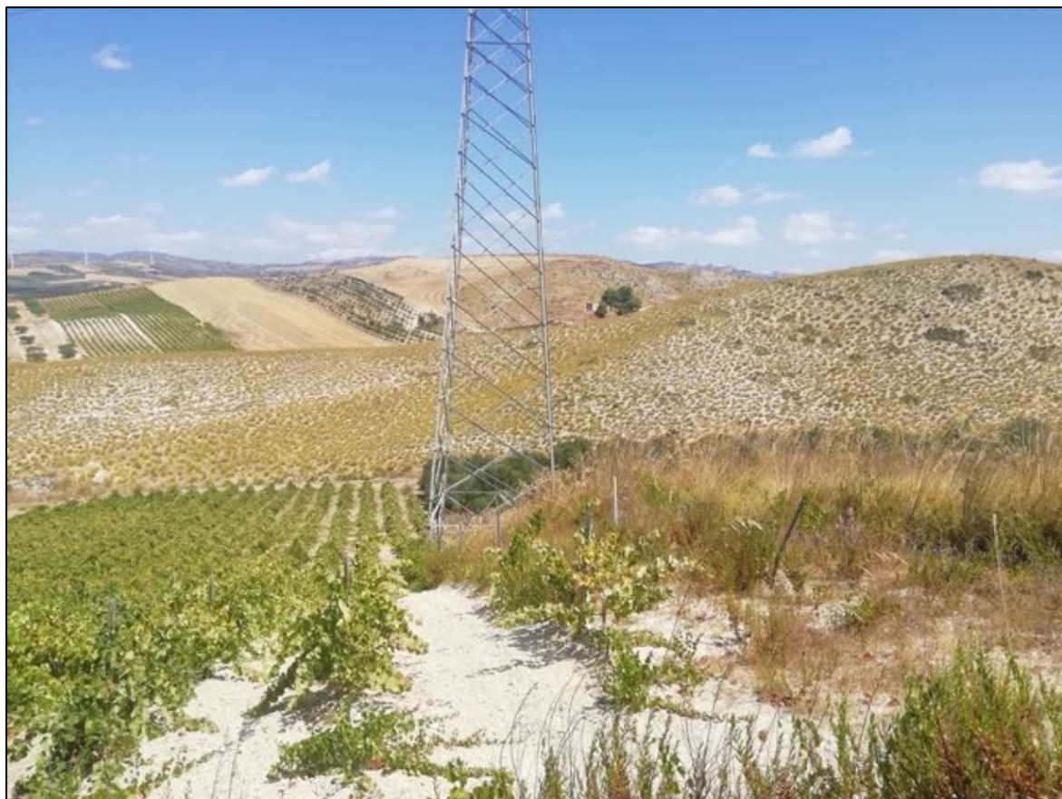
Foto 124: UR 51 (sostegno S15). Vista da sud-ovest verso nord-est.
