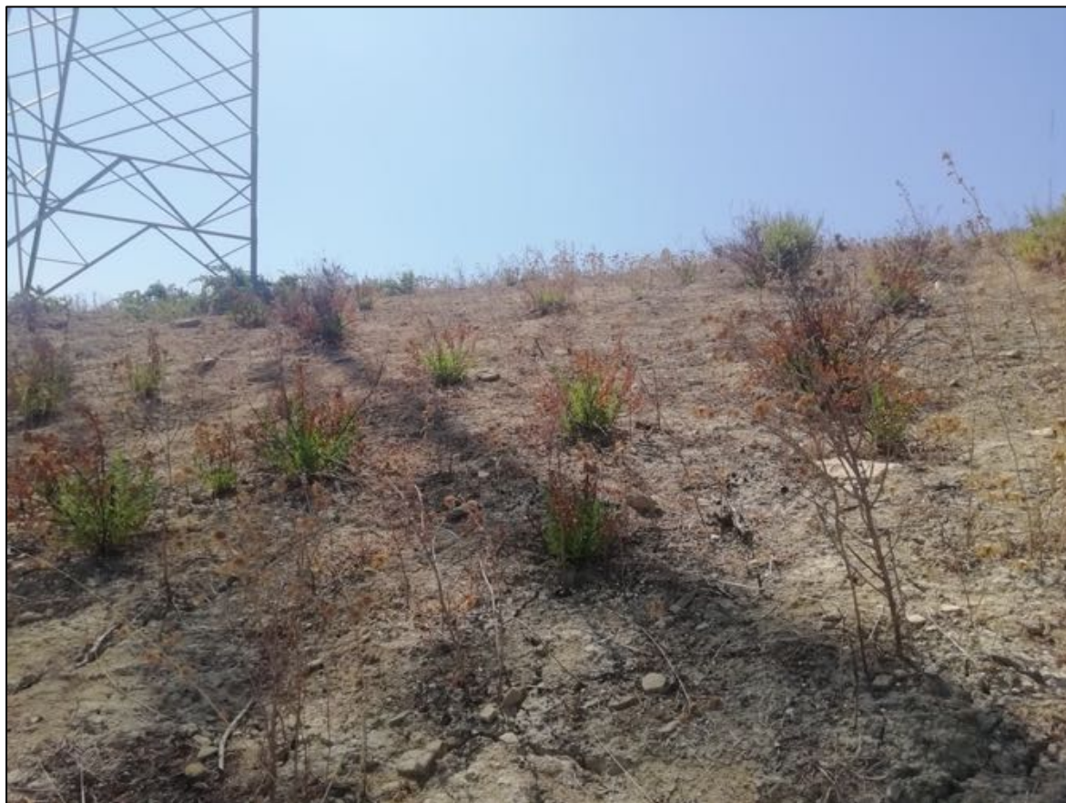
Foto 121: UR 49 (sostegno S13). Vista da nord verso sud.
