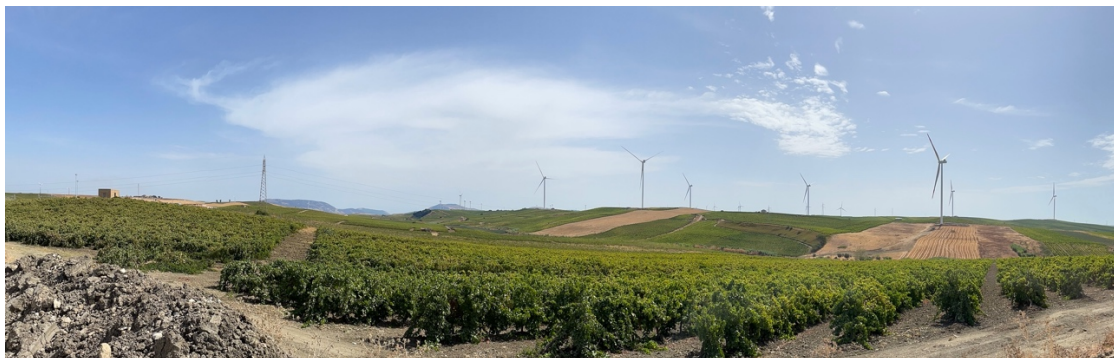
Figura 3-29: Primo tratto su cui si sviluppa il nuovo elettrodotto aereo 220 kV tratto "SE Partanna 2 - SE Partanna 3".
