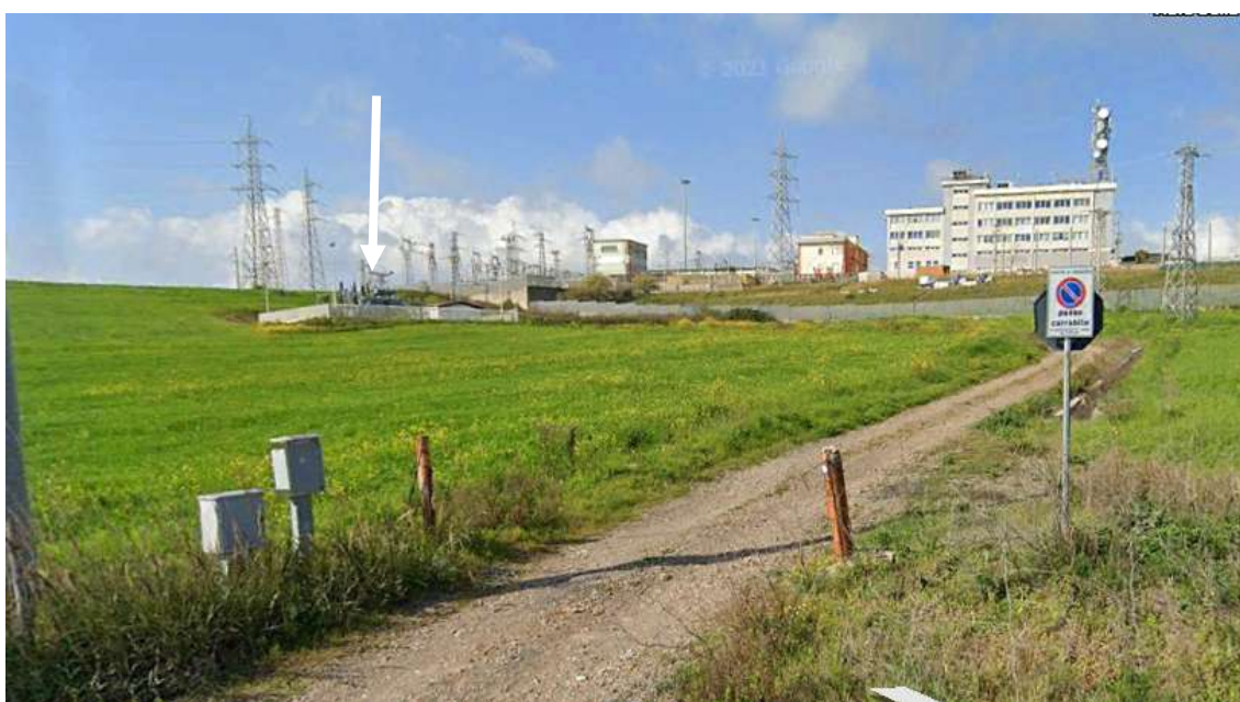
Sito sottostazione di rete
