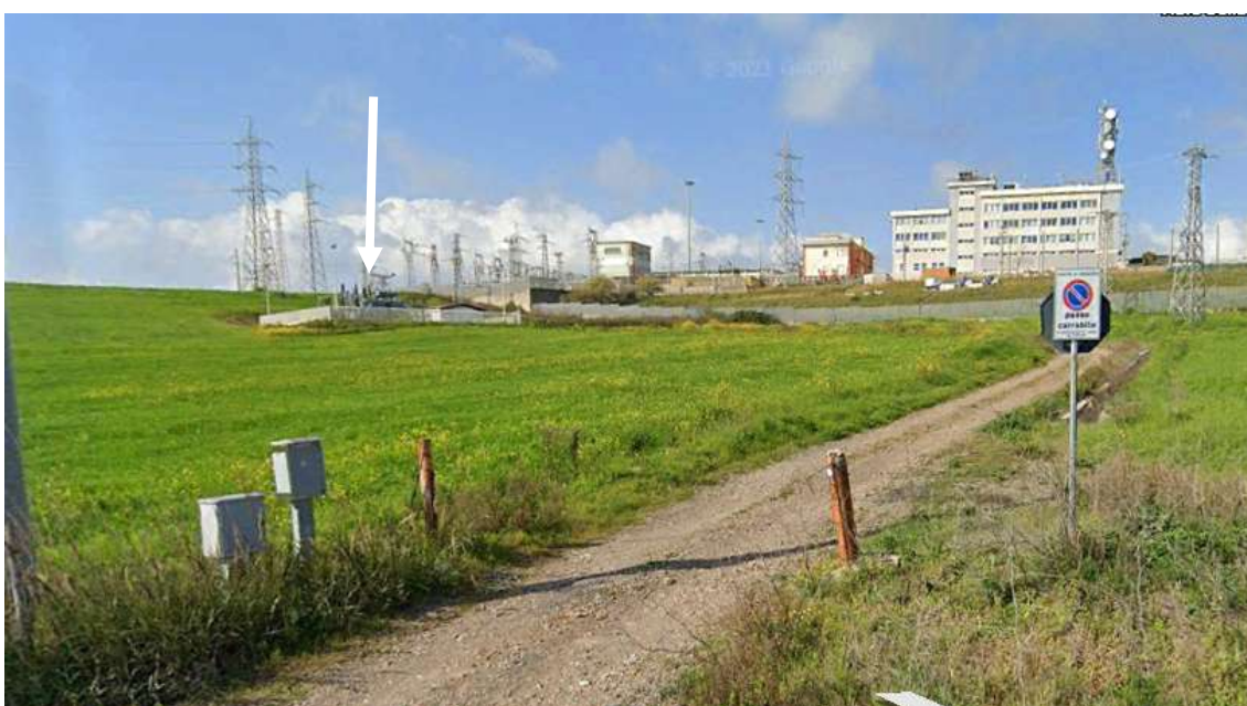
Foto. 41, 42. Sito sottostazione di rete
