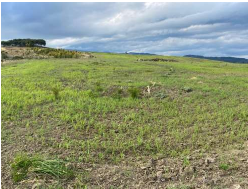
Foto. 18-19. Sito impianto aerogeneratore 5
