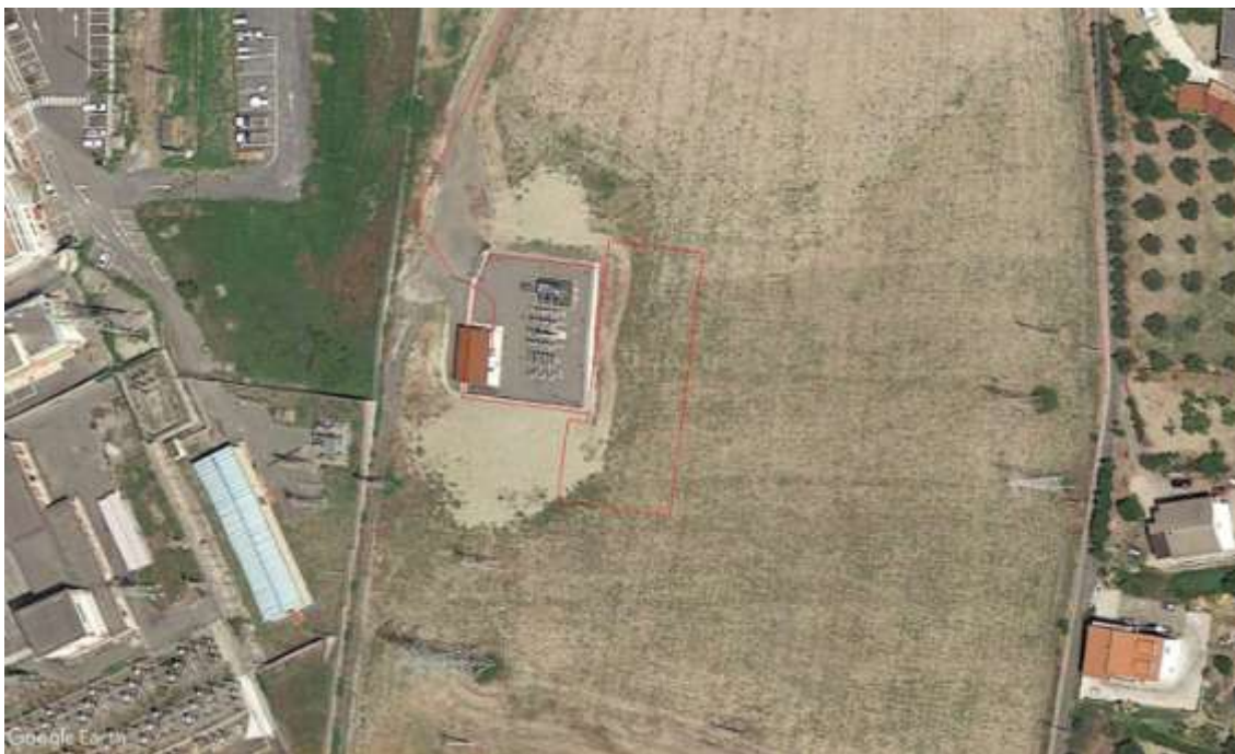
Fig. 71: ortofoto satellitare del 2018 (Google Earth) - Sottostazione
