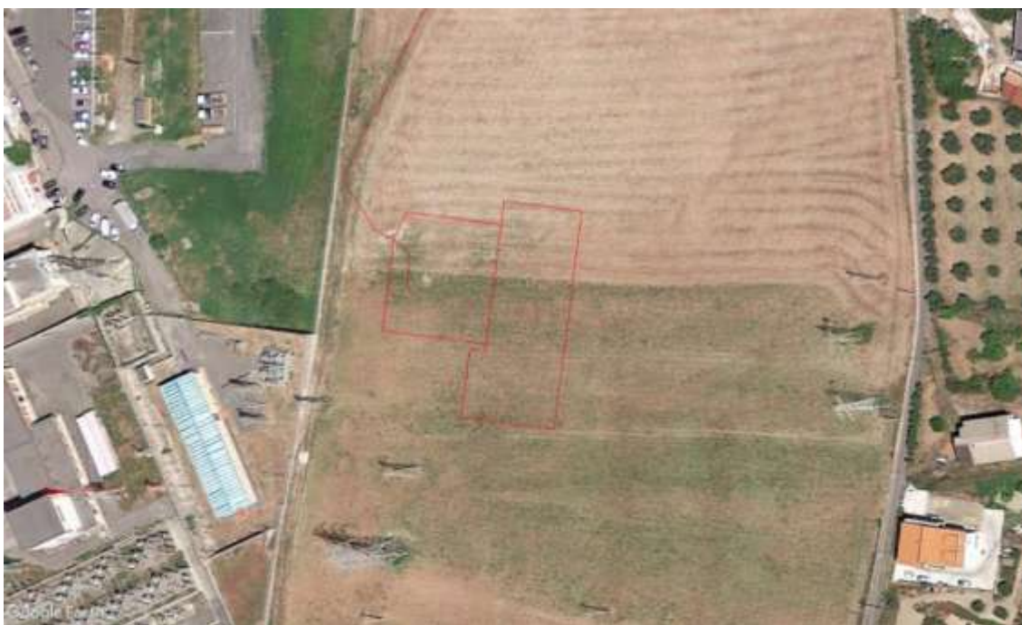
Fig. 72: ortofoto satellitare del 2015 (Google Earth) - Sottostazione
