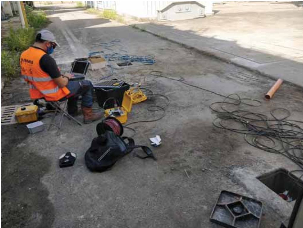
Figura 12 - Fasi di acquisizione della prova Cross Hole.
