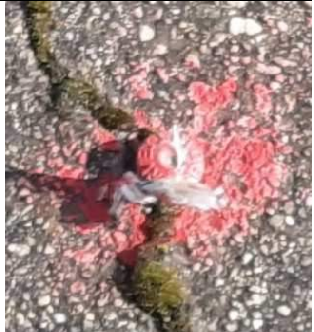
S03-CS2 il caposaldo è incastrato in una fessura
