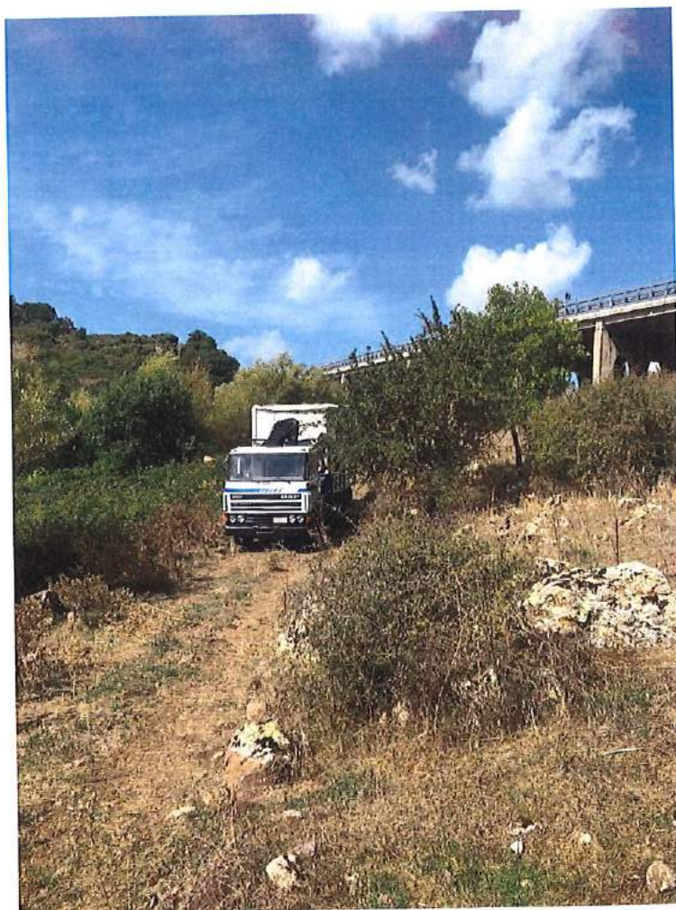
Particolare compressore per esecuzione Sondaggio S2 bis
