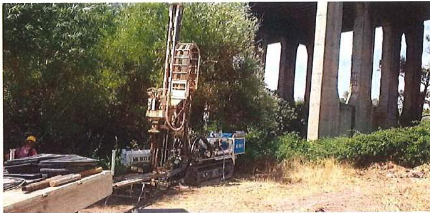
Fig. 2 – Esecuzione del sondaggio mediante perforatrice idraulica MK 900 D
