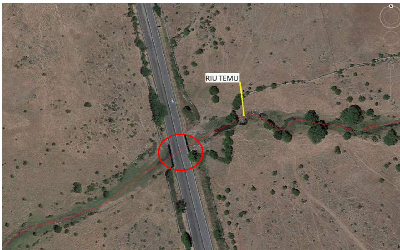
Figura 114 - Inquadramento del corso d'acqua Riu Temo con dettaglio dell'intersezione con la SS 131
