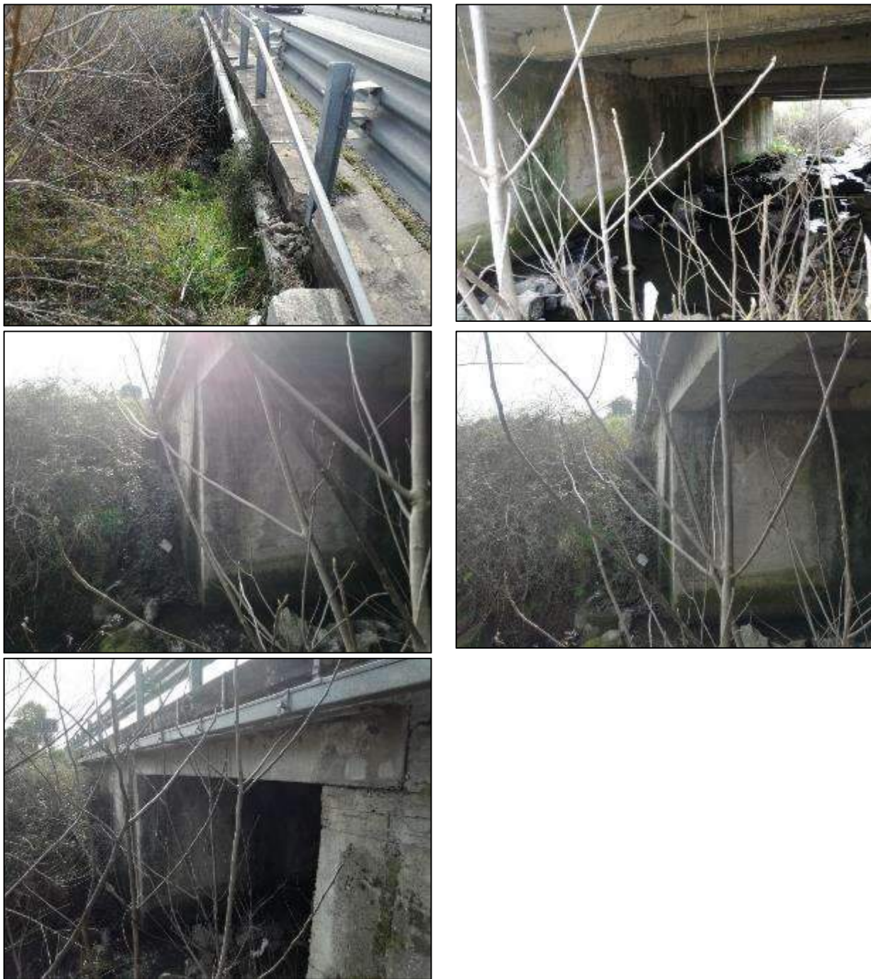
Figura 3 – Documentazione fotografica stato di fatto del manufatto esistente della SS131
