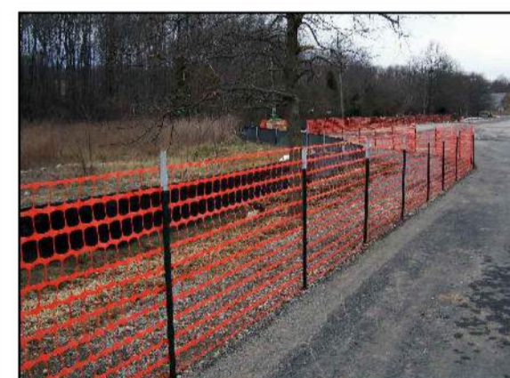
Fig. 2: Recinzione di cantiere in PEad - Tipo R3
