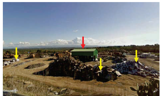
FOTO 3 - Vista generale del piazzale utilizzato come deposito di materiali di cava (freccie in giallo); la freccia in rosso indica invece l'esistente fabbricato metallico a servizio
