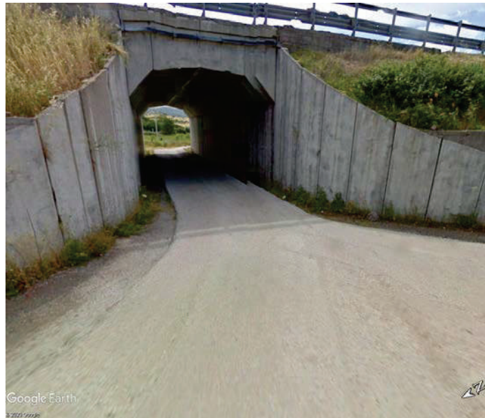
Imbocco sottopasso ferroviario della larghezza di 5,30m
