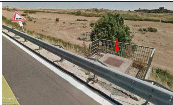
**Foto 44c** - S13 CS: pozzetto rete fibre ottiche sez. 36 con relativo manufatto di protezione.
