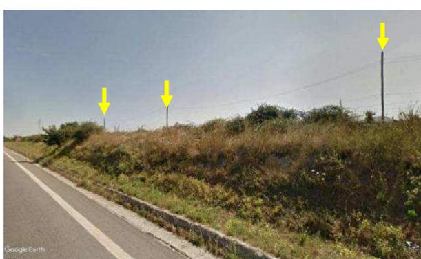
**Foto 19a** - Le frecce gialle indicano i tralicci in legno della linea telefonica e di TD parallela alla carreggiata nord dir. Sassari interferente con il nuovo svincolo.
