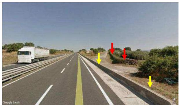
**Foto 36d** - CN: panoramica zona di innesco sez. 92; le frecce rosse indicano i muretti in pietrame; le frecce gialle indicano la cunetta in cls.
