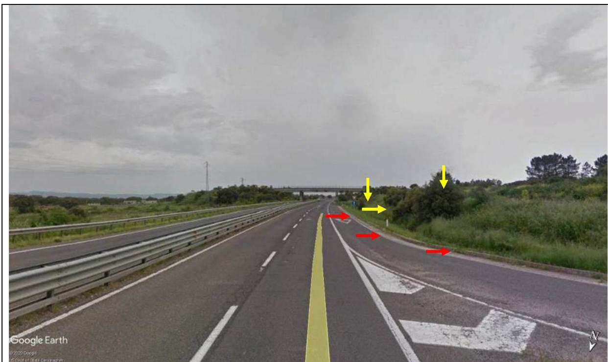
**Foto 26c** - Panoramica area corsia di accelerazione carreggiata sud immissione da Norbello dove si evidenziano: la cunetta in cls (frecce rosse); la scarpata con presenza di essenze arbustive e vegetazione xerofila (frecce gialle)
