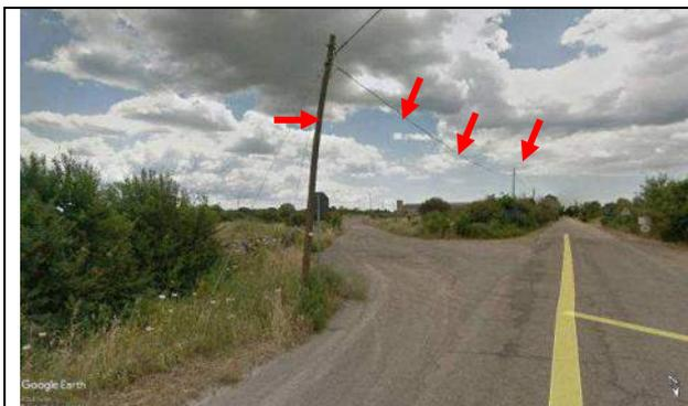
**Foto 34a** - Panoramica area incrocio con via Nazionale; le frecce indicano l'interferenza con in sostegni e la linea telefonica.
