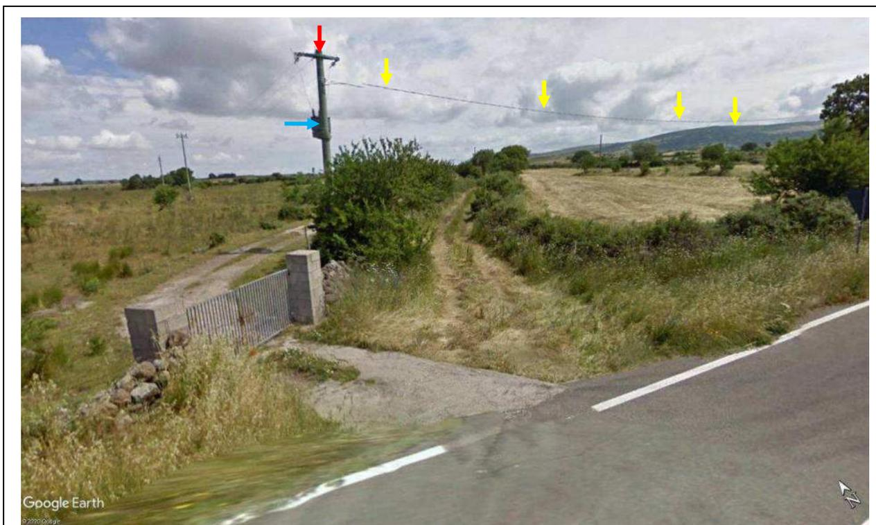
**Foto 19d** - Traliccio della linea Enel di Mt (freccia in rosso) con trasformatore su palo (freccia ciano) e linea elettrica di Bt in derivazione (freccie gialle)
