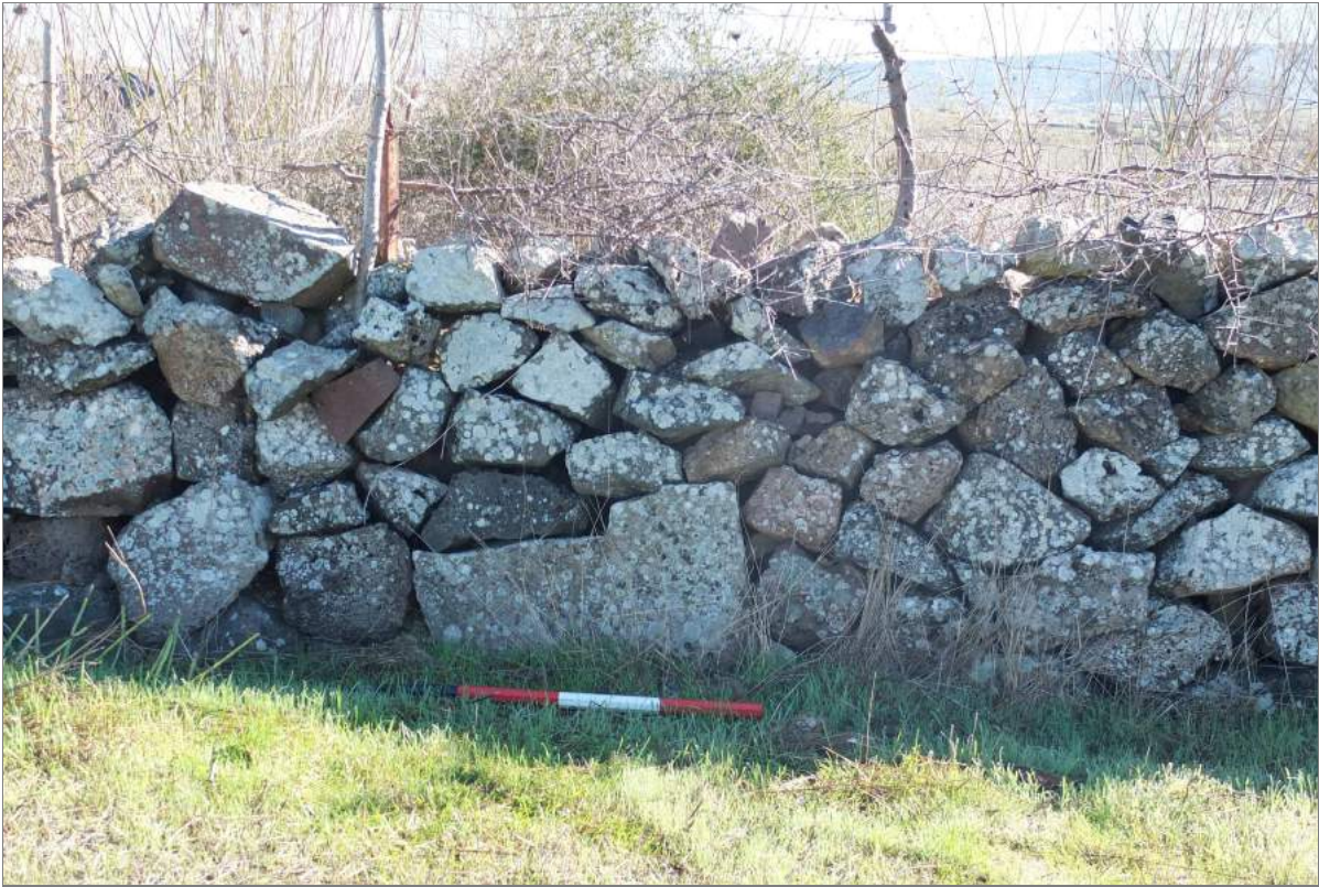
N0004. RCG-1, UT 7. N° 19. Elemento lapideo lavorato riutilizzato nel muro di perimetrazione
