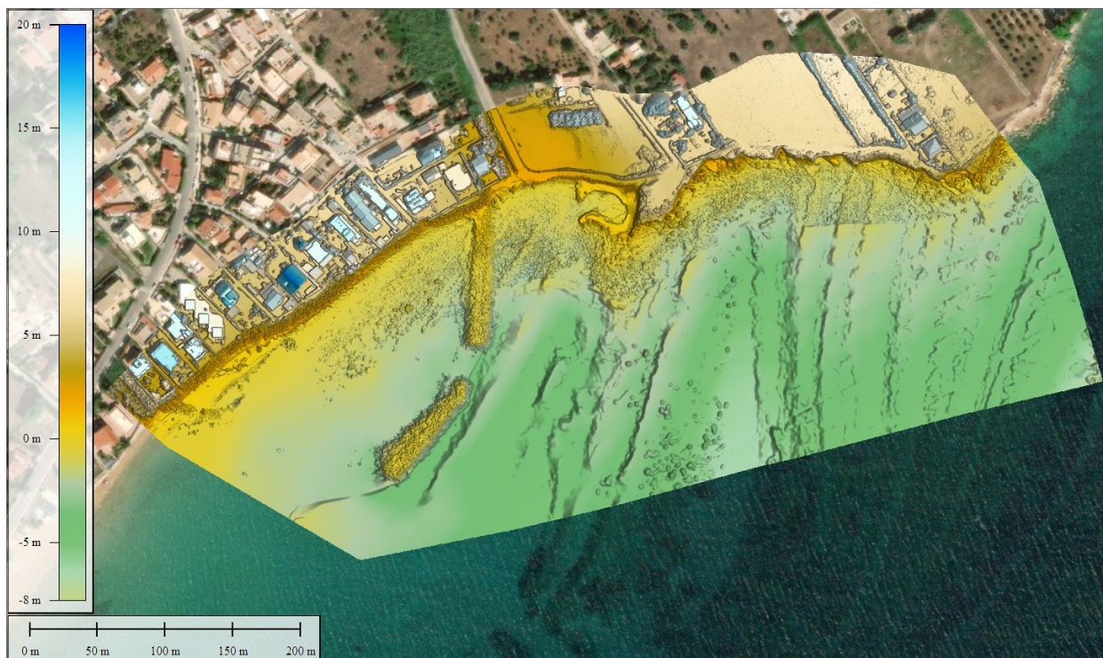
Figura 43 – Avola (ME): modello di elevazione digitale (DEM) generato dalla elaborazione dei dati batimetrici (maglia di acquisizione maglia 0,25x0,25 m e riportato su GIS insieme all'ortofoto dell'area di indagine.
