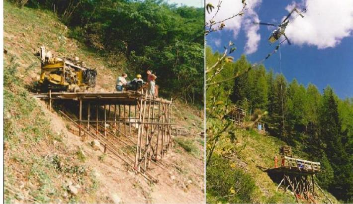
Figura 5. Esempio di piazzola di lavoro e stoccaggio.
