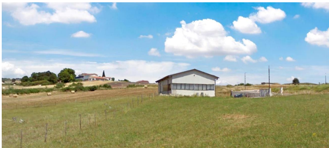
Figura 9-30 - Area Rilevato- Stato ante operam
