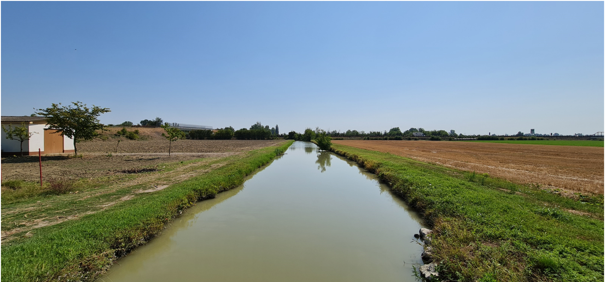
(0) Il Canale di Budrione dal ponte sulla strada comunale Via Paoletta Arginello che si snoda a Ovest dell'autostrada. Sullo sfondo, il rilevato autostradale; a sinistra il sovrappasso di via Budrione di Migliarina.
