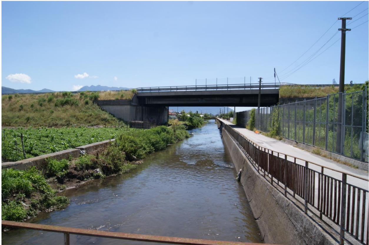
Figura 8-4: – Ripresa verso la SS 268 dalla SP127 nel comune di Scafati (SA)
