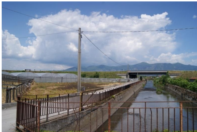
Figura 6-1: Il canale del Fiume Sarno in primo piano e il viadotto esistente della SS 268
