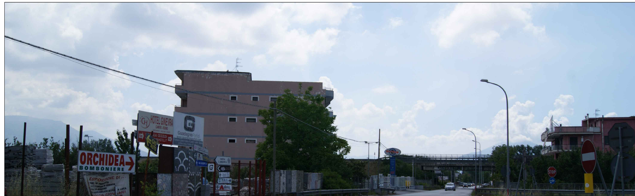
Punto di ripresa n.2 - Via Vecchia Poggiomarino Muscettoli frazione del Comune San Giuseppe Vesuviano (NA)
