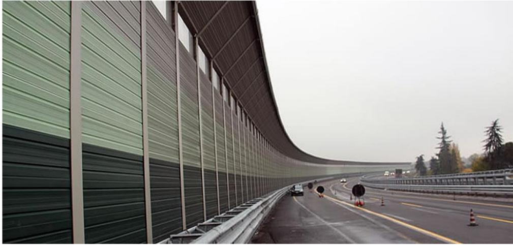
*Figura 10-11: Esempio di barriera antirumore*
