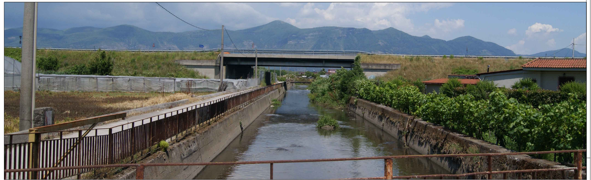
Punto di ripresa n.22 - Via Traversa Morena Comune di Scafati (SA)
