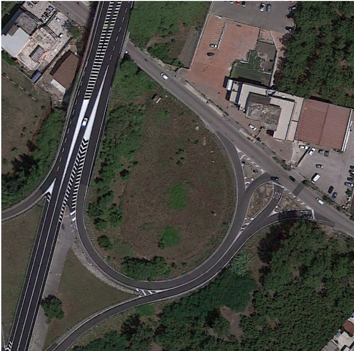
Vista dall'alto dell'area del cantiere
