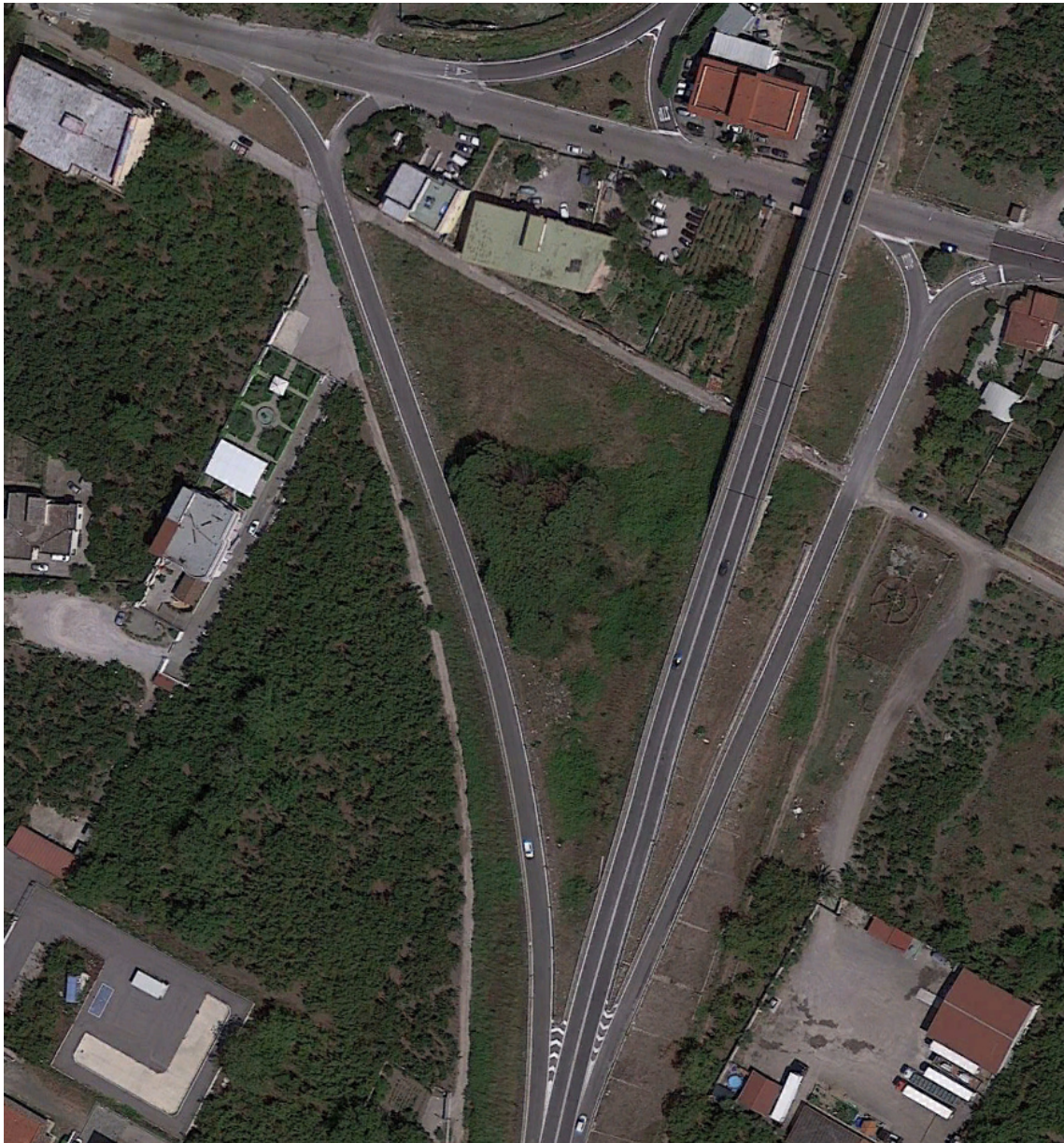
Vista dall'alto dell'area del cantiere
