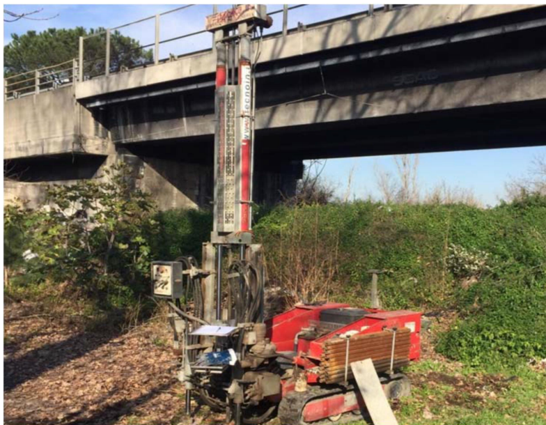
Figura 39 – Esecuzione prova DPSH in sito
