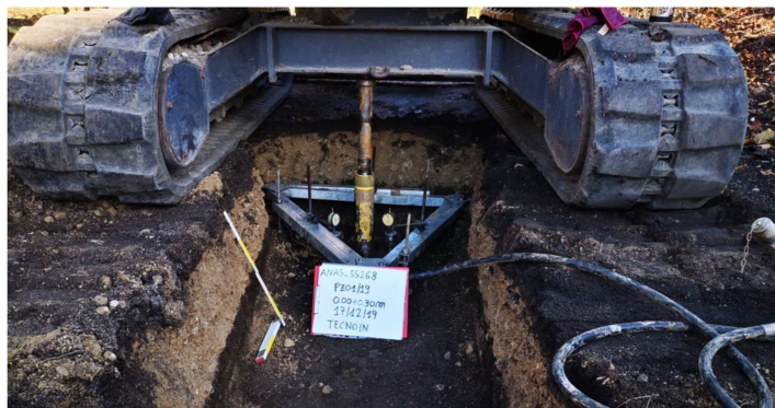
Figura 48 – Esecuzione prova di carico su piastra in sito.
