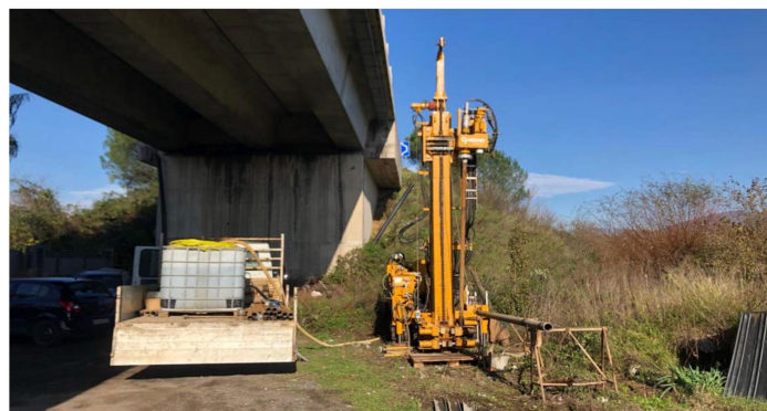
Figura 29 – Esecuzione di un sondaggio geognostico in sito
