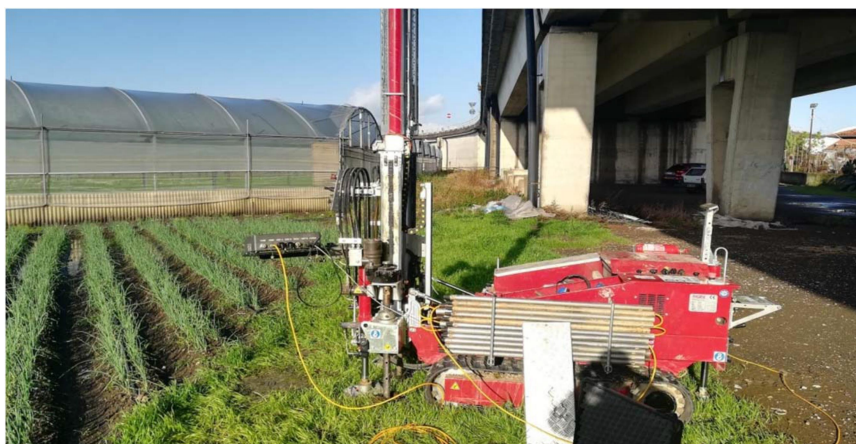
Figura 31 – Esecuzione prova CPT in sito
