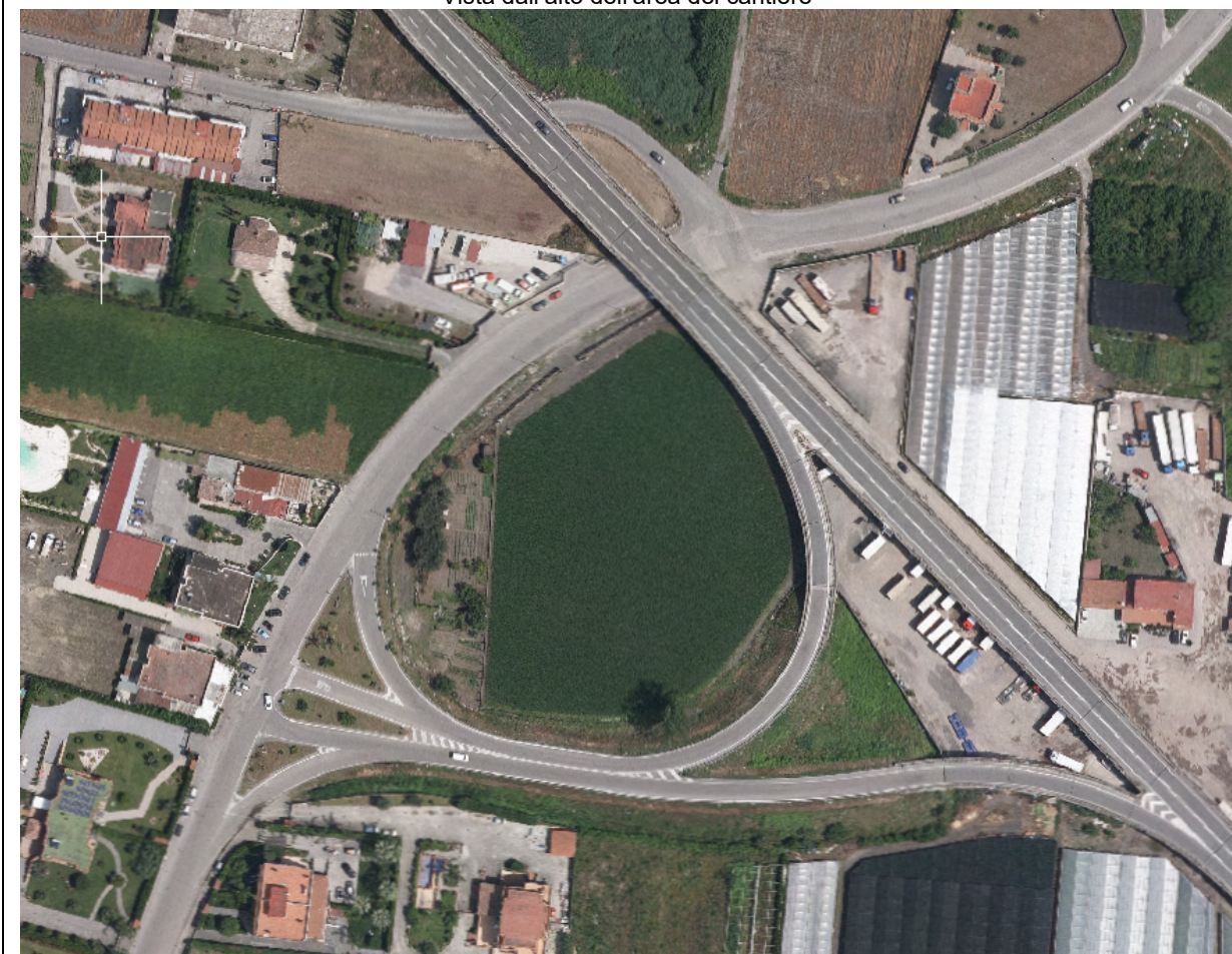
Vista dall'alto dell'area del cantiere
