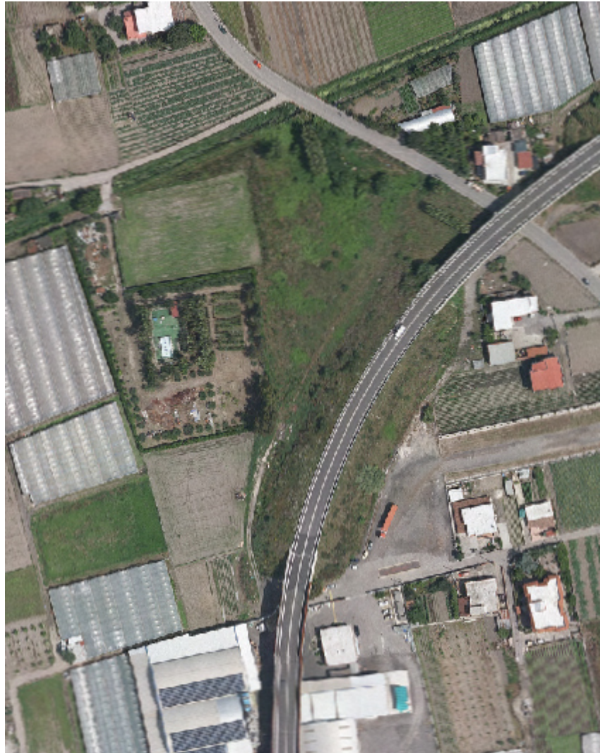
Vista dall'alto dell'area del cantiere
