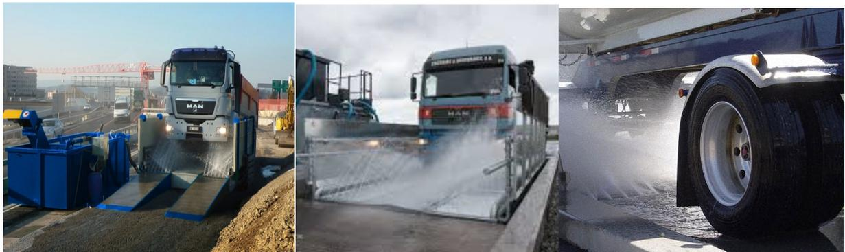
*Figura 2 – Esempi di sistemi di lavaggio degli pneumatici (A PRESSIONE).*
